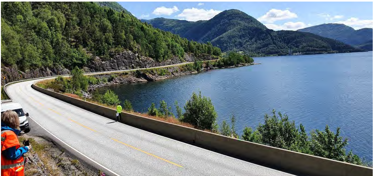
Figur 3-25: Rv. 5 Furevika med utsyn mot Erdal og anlegget på Smedneset i bakgrunn og vegen vidare mot Smedneset
