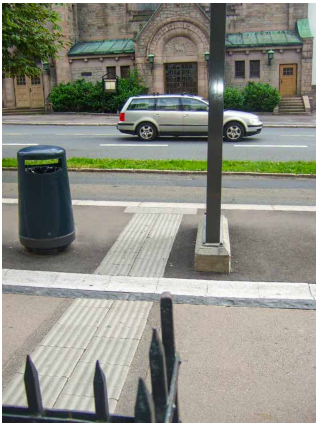
Fra Frogner i Oslo. Det er lagt et oppmerksomhetsfelt i god kontrastfarge over hele fortauets bredde. Det gjør at synshemmede som går langs gjerdet på fortauet får informasjon om at de befinner seg ved en holdeplass eller et gangfelt. I dette tilfellet ender linja mot veibanen med oppmerksomhetsindikatorer (heller med stripene på tvers), som betyr at dette er en holdeplass. (Foto: Randi K. Øverland)
