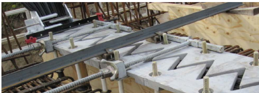
Figur 7 Montasjebjelke, oppspenningsutstyr og gjengestang for montasje i fugeende (foto: Gaute Nordbotten)
