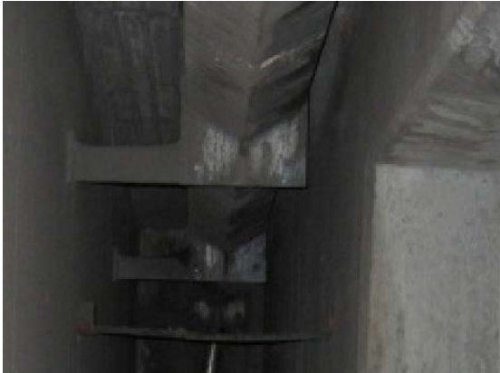
Figur 3 Renne under fuger (foto: Gaute Nordbotten)
