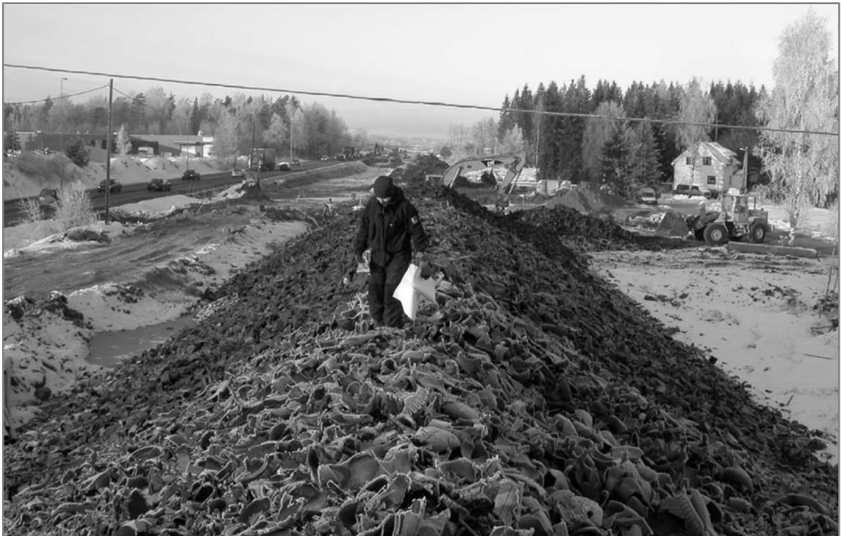
Figur 1. Støyvoll ved Huggenes. Lett kjerne av oppkuttet bildekk.
