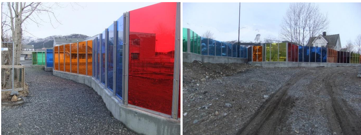
Figur 12: Bilde som viser støyskjermer under oppføring ved Velle barneskole
