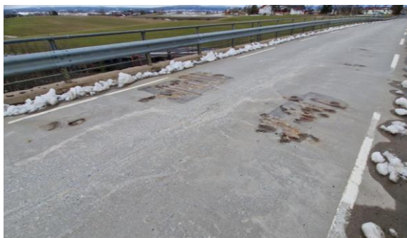
Foto: Skader i brudekke og -rekkverk
