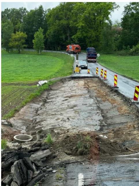
Foto: Smal fv. med jord og leirmasse rett under asfaltdekke
