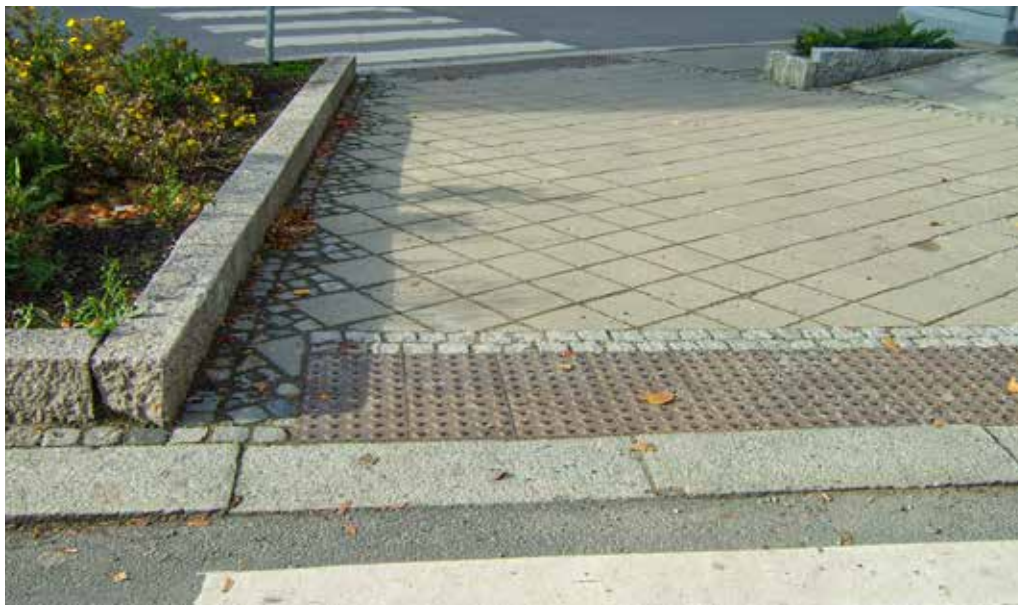
Fra Lillehammer. Varselsindikatorer i støpejern har god kontrast til betongheller. Den 30 cm brede kantsteinen fungerer som nedramping og avsluttes med en kant på 2 cm, slik at en kan ta ut gangretningen med hælene mot kanten. Kanten på blomsterbedet utgjør en naturlig ledelinje fram til neste krysningspunkt. (Foto: Randi K. Øverland)
