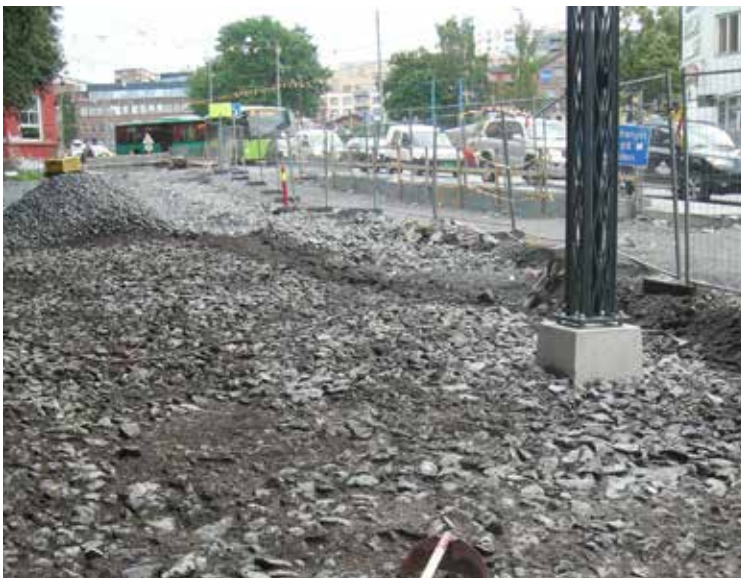
Figur 32 Rotvennlig forsterkningslag som er lagt i fortausarealer i tilknytning til trær Foto: Ingjerd Solfjeld
