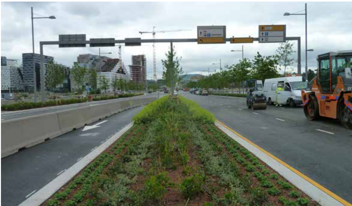
Figur 14 Nyplantede stauder og klatreplanter i midtrabatt. Det er plantet tett for å få rask dekking av jorda og dermed redusere problem med ugras. Foto: Ingjerd Solfeld
