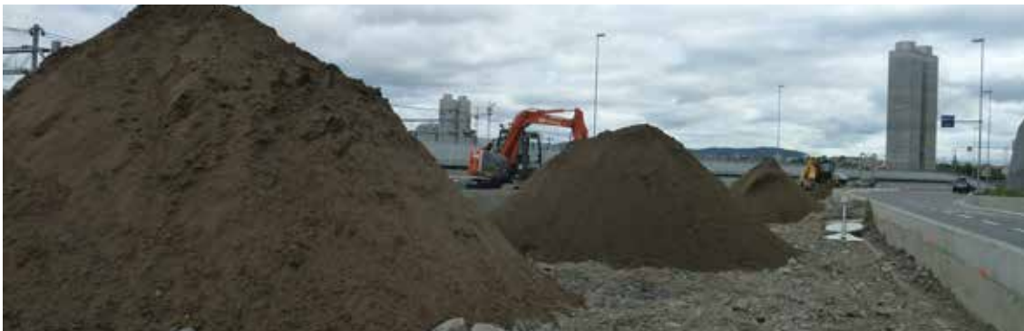
Figur 8 Produsert vekstjord som er tilkjørt til et område der den eksisterende massen er ubrukelig til plantevekst
