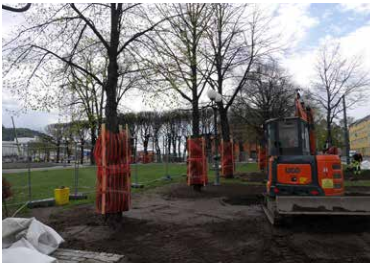
Figur 23 og 24 Trær som skal bevares gjennom byggeprosjekter må beskyttes fysisk. Bildekk og plastgjerde er et godt alternativ. Et annet alternativ er gjerde som hindrer ferdsel i rotsonen og holder maskiner på avstand.
