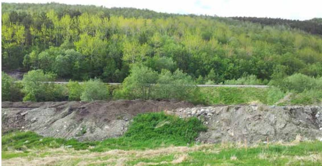
Figur 9 Eksempel fra riksveg 80 Loding–Vikan på at toppjord med innhold av aggressivt ugras er lagt i «rent» deponi. Deponiet var i konkurransegrunnlaget forbeholdt undergrunnsjord som skulle brukes til produksjon av vekstmedium. Foto: Elisabet Kongsbakk
