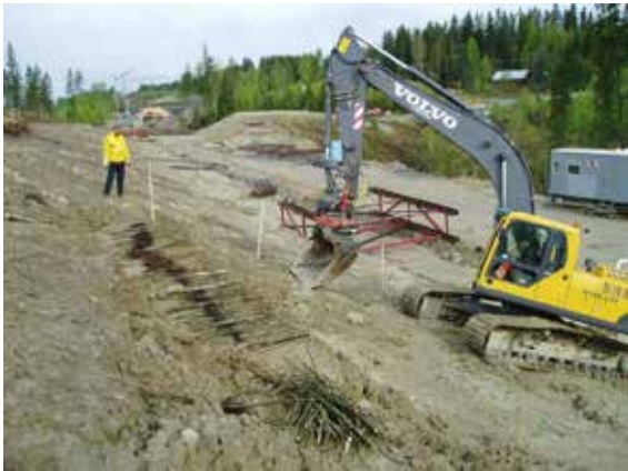
Figure 42 Arbeide med utlegging av stiklinger etter lagermetoden. Foto: Statens geotekniske institut, Linköping, Sverige. Gjengitt med tillatelse.
