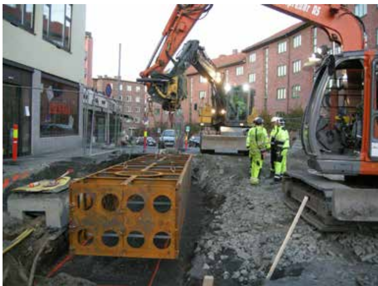
Figur 33 Plantekasse på 9 meter, sammensatt av 3 kasseelementer av støpejern heises på plass, Carl Berners plass i Oslo Foto: Ingjerd Solfeld
