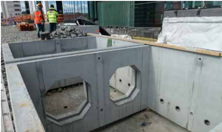
Figur 31 Plantekasser av betong som er produsert til prosjektet kan tilpasses med de mål som plassen tillater. Foto: Ingjerd Solfjeld
