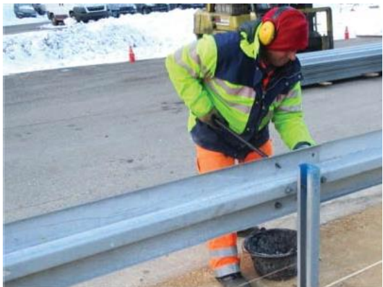
4.10 Vormontage der Verschraubung per Hand Pre-mounting the system
