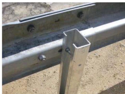
5.6 Verschraubung Rückseite im Stoßbereich der Holme
