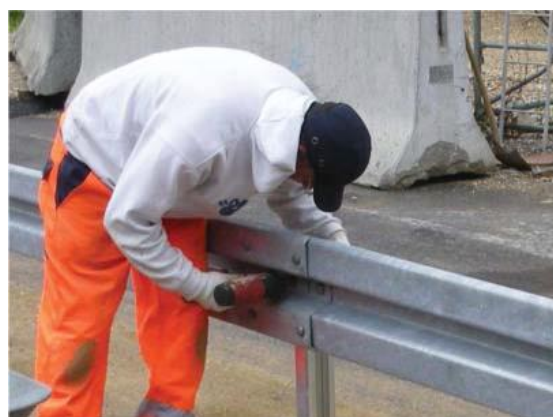
4.12 Festziehen der Schrauben... Tightening the screws...
