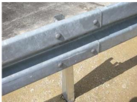
5.5 Verschraubung Vorderseite im Stoßbereich der Holme
