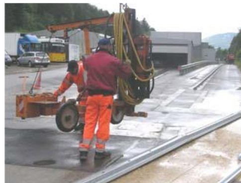
4.6 Aufbauen der Ramme Preparing the pile driver
