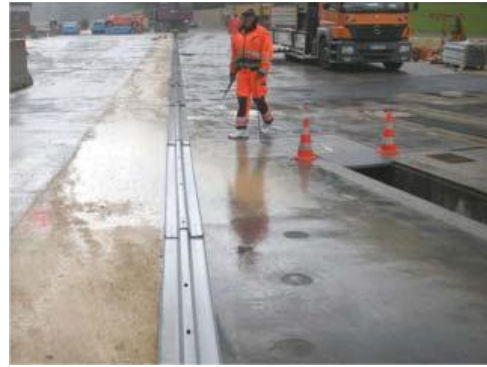
4.4 Ausrichten der SP-Holme Aligning the beams
