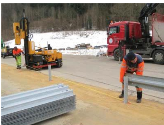
4.11 Montage erfolgt Zug um Zug mit dem Rammen der Pfosten Mounting follows step by step the piling frame
