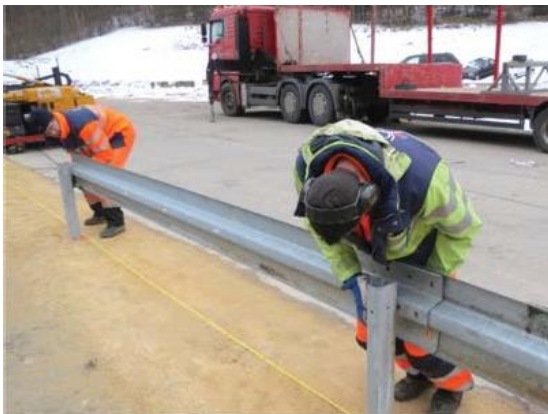
4.9 Anhängend der SP-Holme Fixation of the beams
