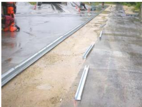
4.5 Auslegen der Pfosten Placing of the posts
