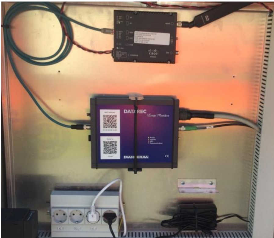
Figur 3. Eksempel på en Loop Monitor sykkel som er hengt opp ved hjelp av vinkelfester og strips. Det er ikke en løsning som blir levert av utstyrsleverandøren.
