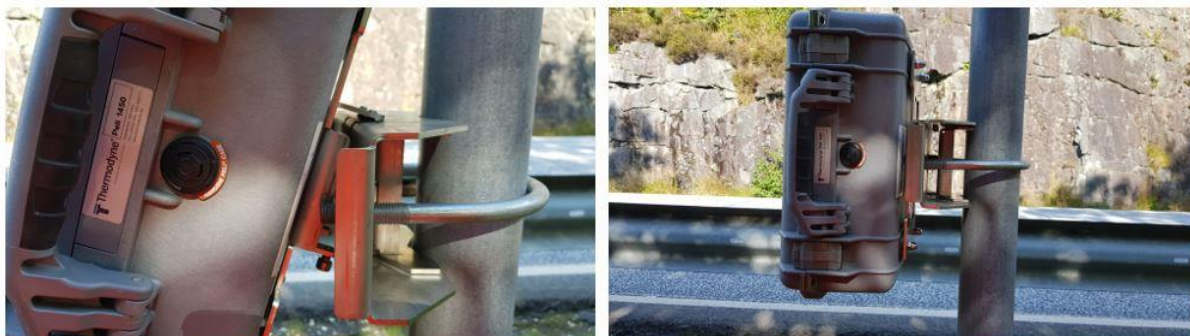
Figur 9. Montering av Topo til brakett.
