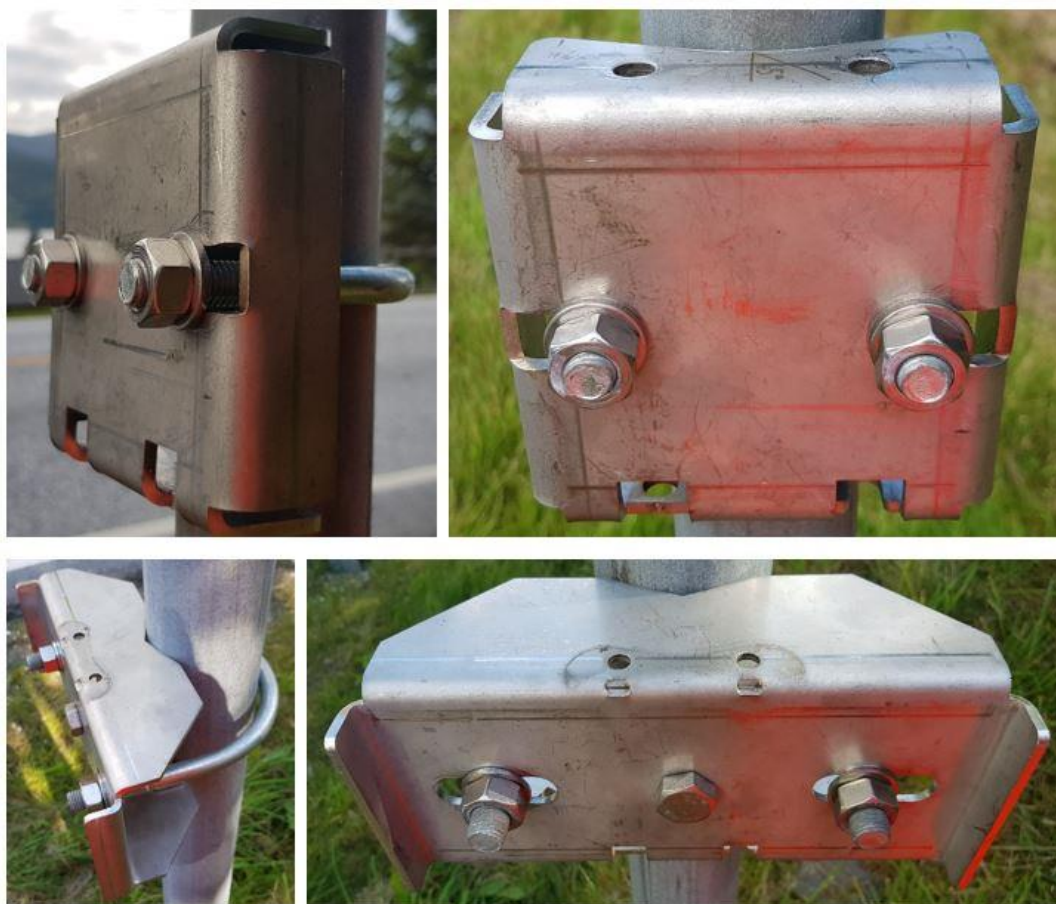
Figur 8. Brakettene festet til stolpe.
