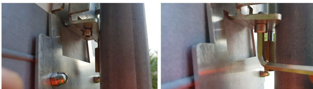
Figur 14. Låse fast Topo til braketten med unbrakonøkkel.
