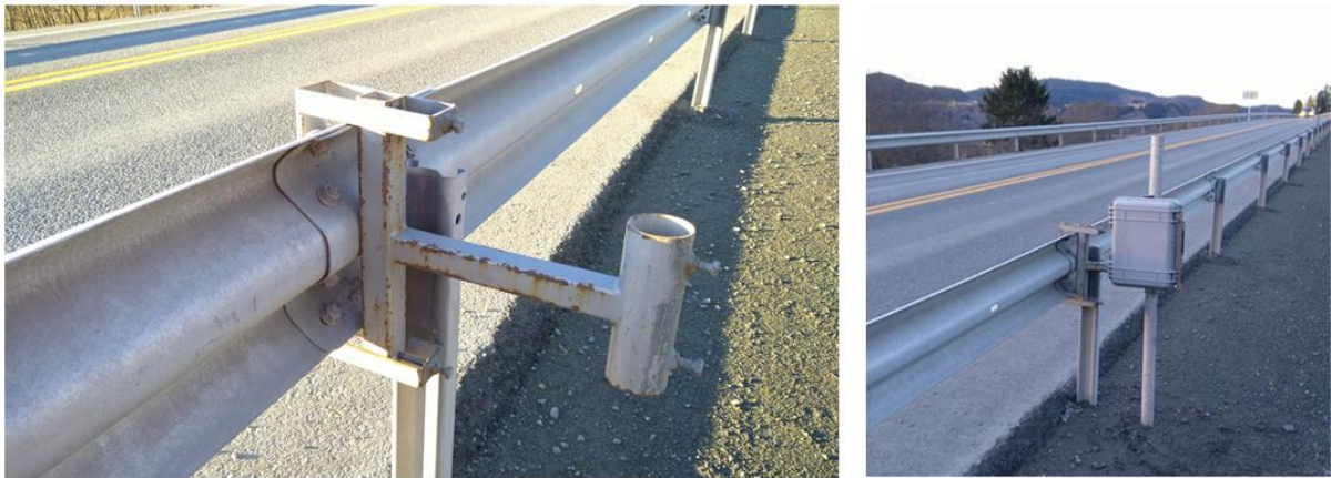
Figur 15. Montering på rekkverk.
