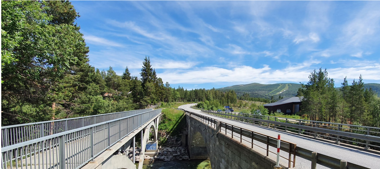
Figur 2 Bildet av E136 Romsdalsveien retning mot øst (Dombås) . Ny bru bygges til høyre(nedstrøms) for dagens E136 bru. Dagens E136 bru beholdes som gang-/sykkelveibru og dagens gang-/sykkelvei bru rives.
