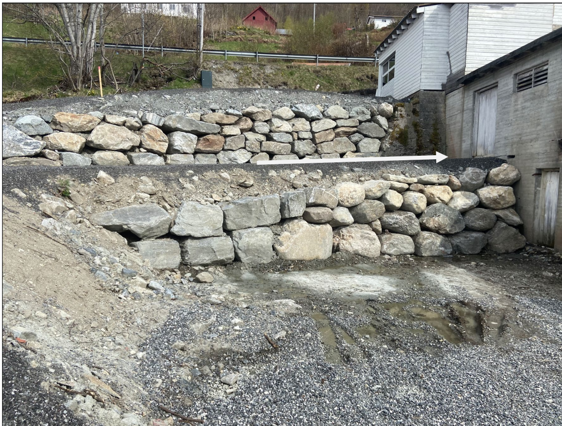
Figur 2: Bilde viser nordsiden av møbelfabrikken, en eventuell støttemur vurderes på nivå ved pila slik at midtre del av bygget kan bevares.
