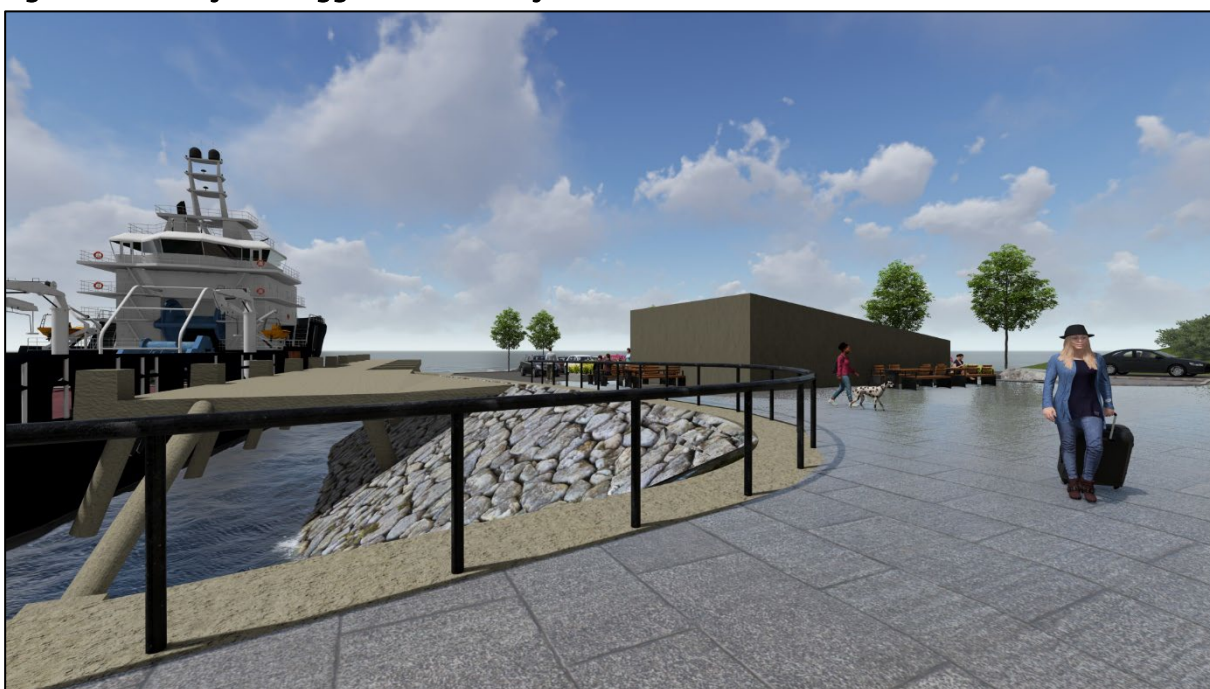
Figur 22 Liggekai med ny steinplastring mot land
