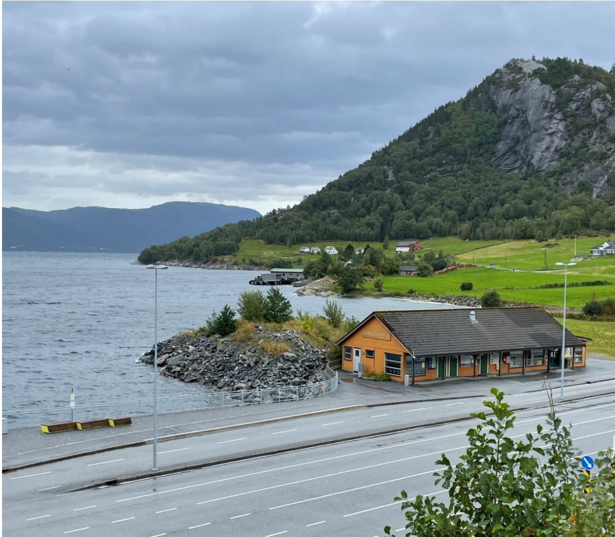
Figur 8 Bilete av eksisterande fylling mot sjø og servicebygg.
