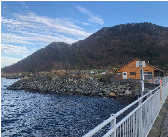
Figur 14 Dagens servicebygg har tidlegare romma butikklokale/kafe men er alt for stort for dagens bruk. Det vert difor planlagt for at dette bygget skal erstattast med eit nytt, mindre servicebygg.
