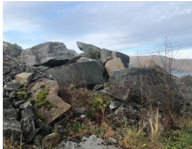
Figur 15 I fyllinga bak servicebygget er det tippa sprengstein av store dimensjonar.
