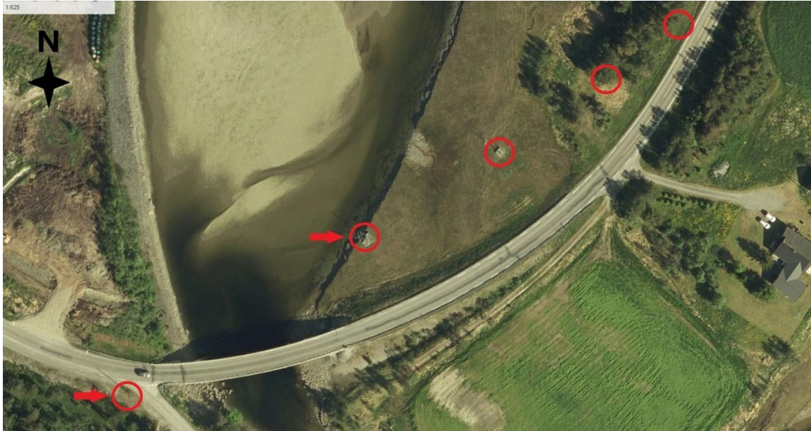
Figur 47: Ortofoto som viser telefonstolper på den vernede linjekursen. Stolpene er markert med røde sirkler. To røde piler markerer stolper med skadede fundamenter. Foto: Statens vegvesen.
