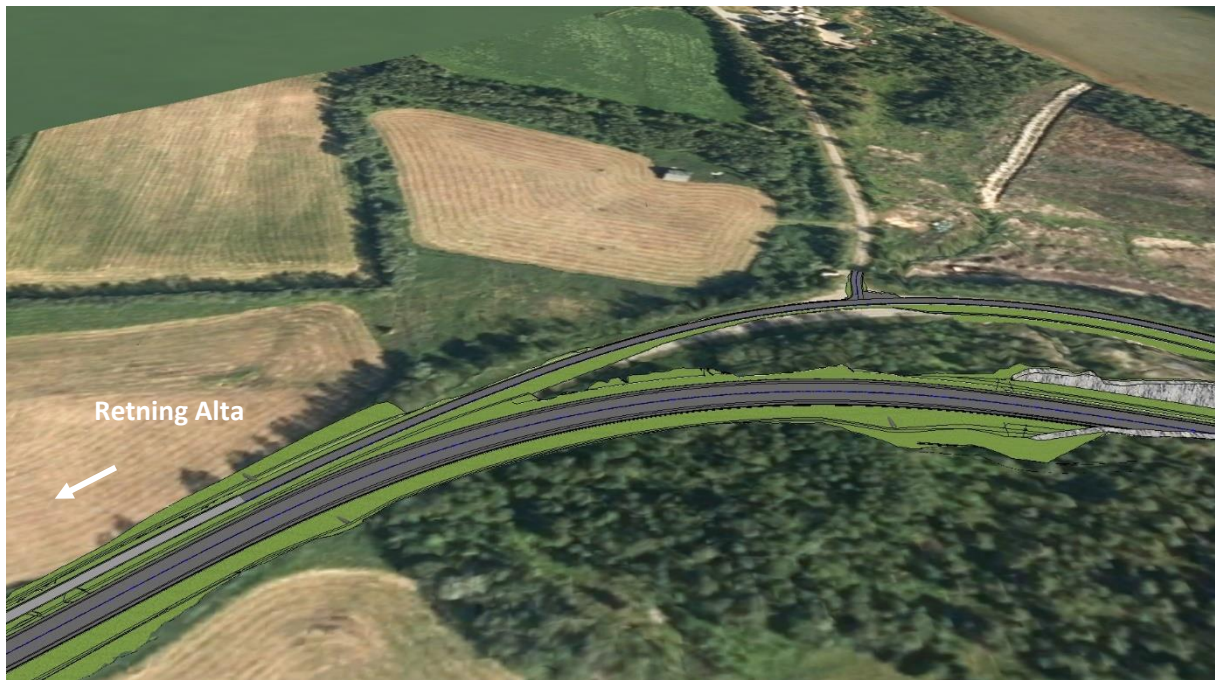
Figur 8: Nærbilde av veganlegget videre østover hvor fremtidig gang-/sykkelveg vil følge dagens vegtrasé, mens E6 vil følge en rettere vegtrasé og legges i bergskjæring (så vidt synlig i lyst grått til høyre i bildet). Bildet er sett mot nord.
