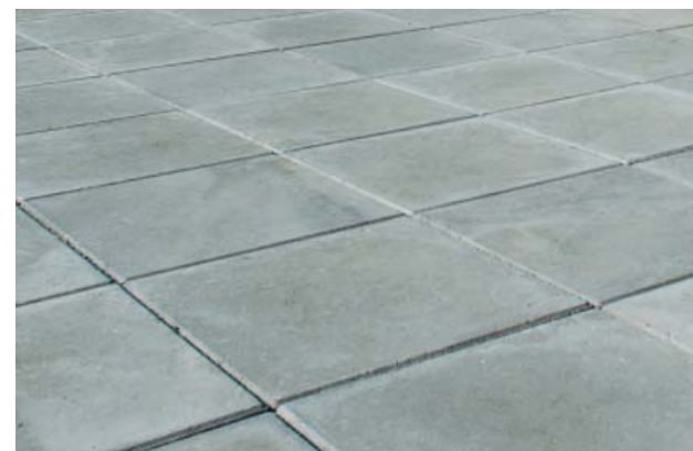
Betongheller. Foto: asak.no
