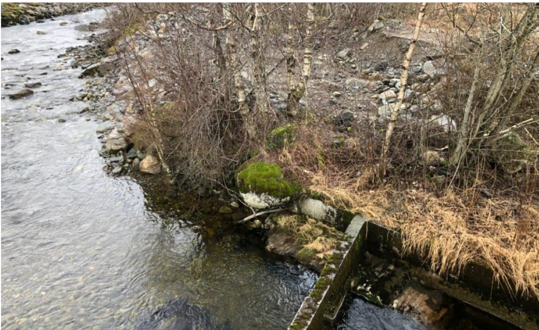
Figur 19: Utgraving ved Austre landkar. Grove massar (grus). Konstruksjonen nedst i bilete er del av laksetrapp .
