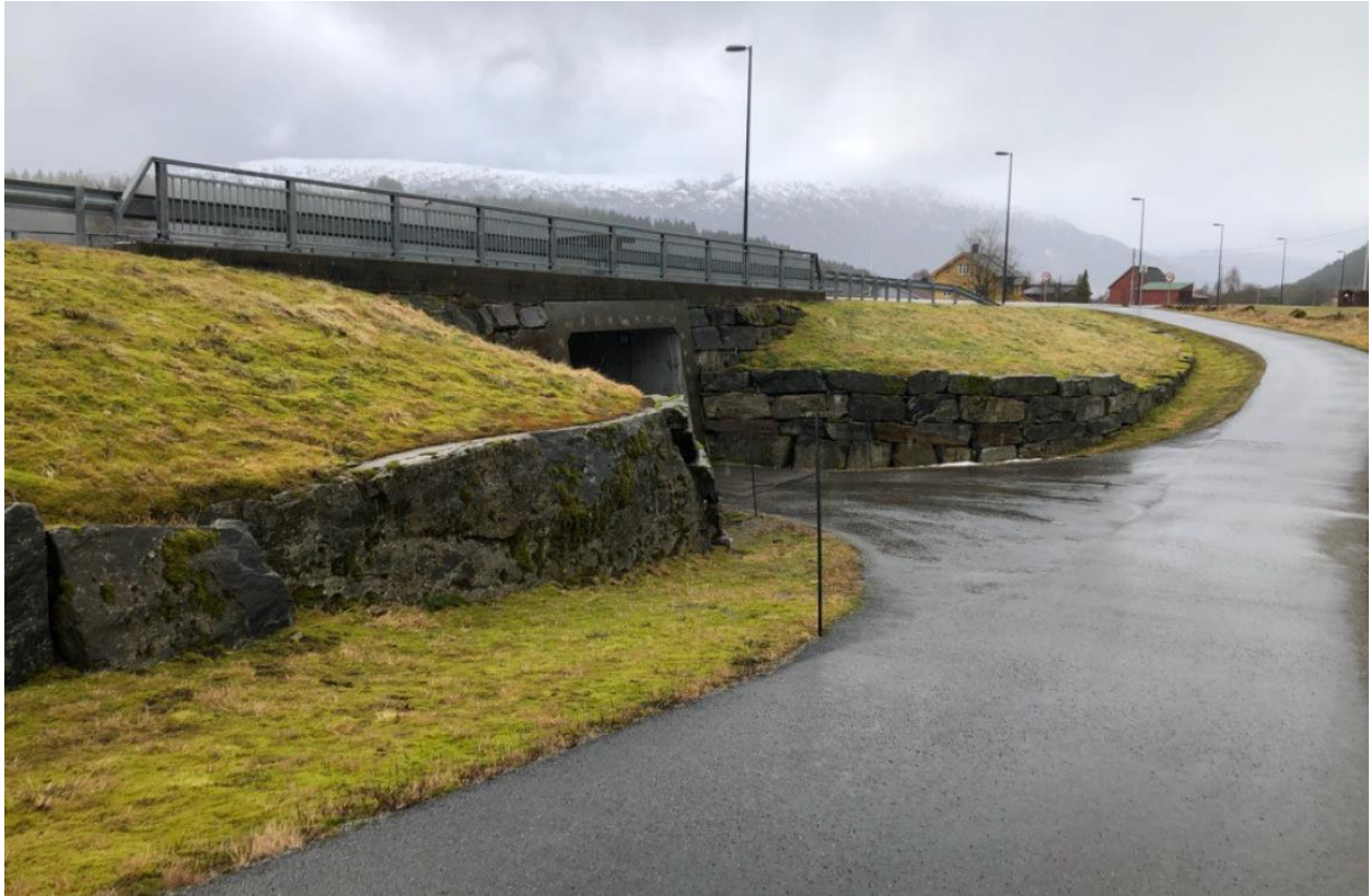
Figur 20: Berg i dagen ved GS-undergang i vest.
