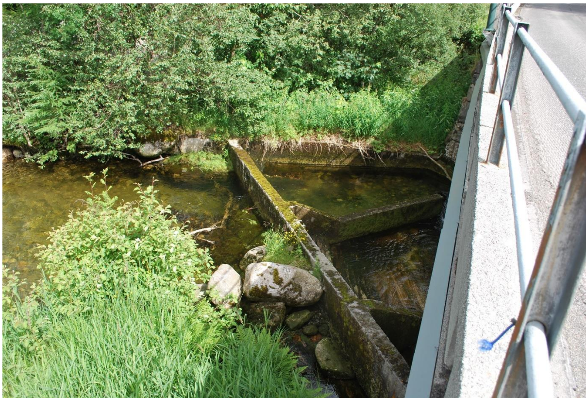
Figur 13 Laksetrappa oppstrøms brua. Foto: Marit Anita Skrede, Statens vegvesen 2022
