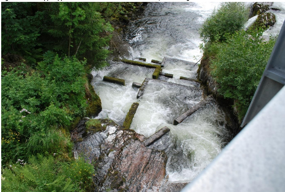
Figur 14. Laksetrappa nedstrøms brua. Foto: Marit Anita Skrede, Statens vegvesen 2022
