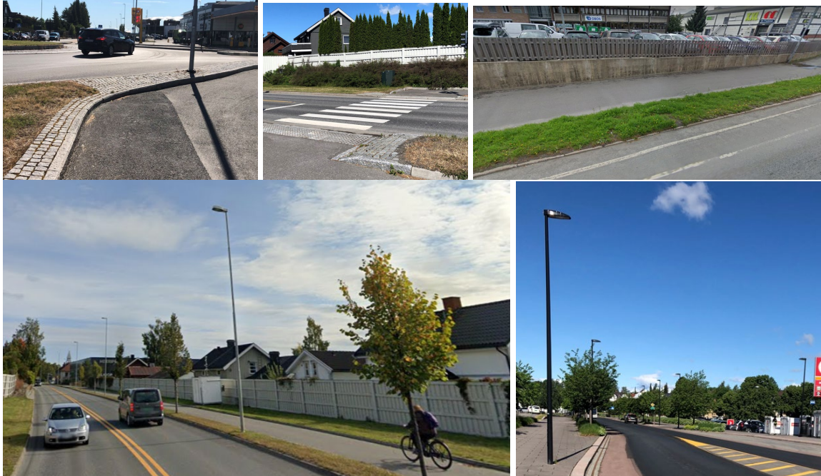
Figur 16 Materialvalget langs Vangsvegen varierer med bruk av granittkantstein, smågatestein og betong kantstein.
