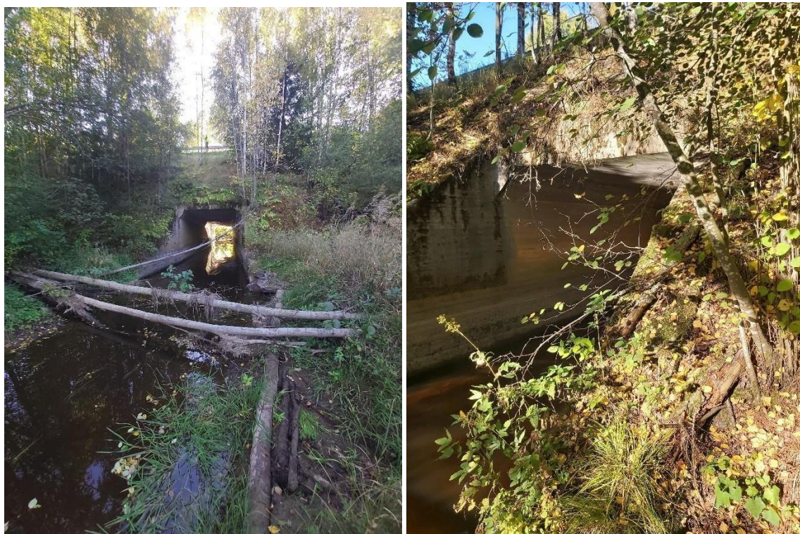
Figur 1.3: Innløp (t.v.) og utløp (t.h.) på eksisterende kulvert.
