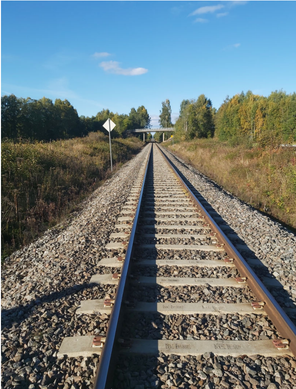
Figur 7 Bilde av eksisterende jernbane med grøft for avrenning
