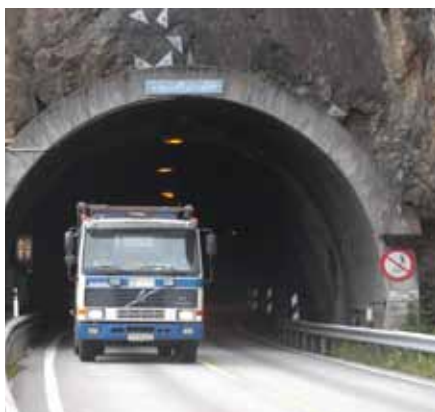
Vallaviktunnelen blir stengt i åtte veker i haust. (Foto: Geir Brekke)
