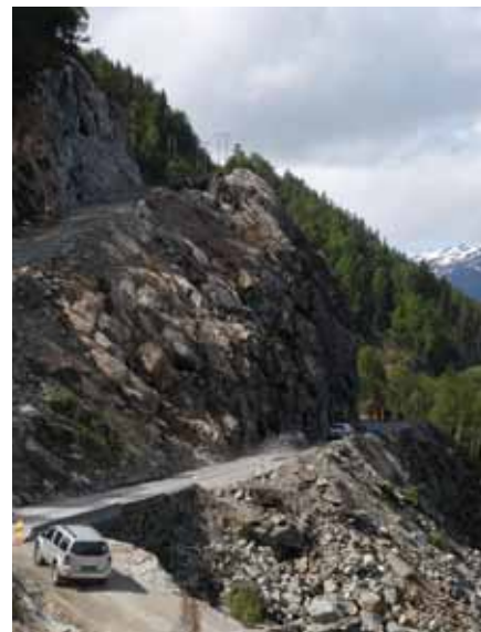
Det er nedsprenjing av fjellpartiet Høgasteg som krev full stenging av rv. 13 Bu–Brimnes i tre veker, frå 31. august til 21. september i år. (Foto: Geir Brekke)
