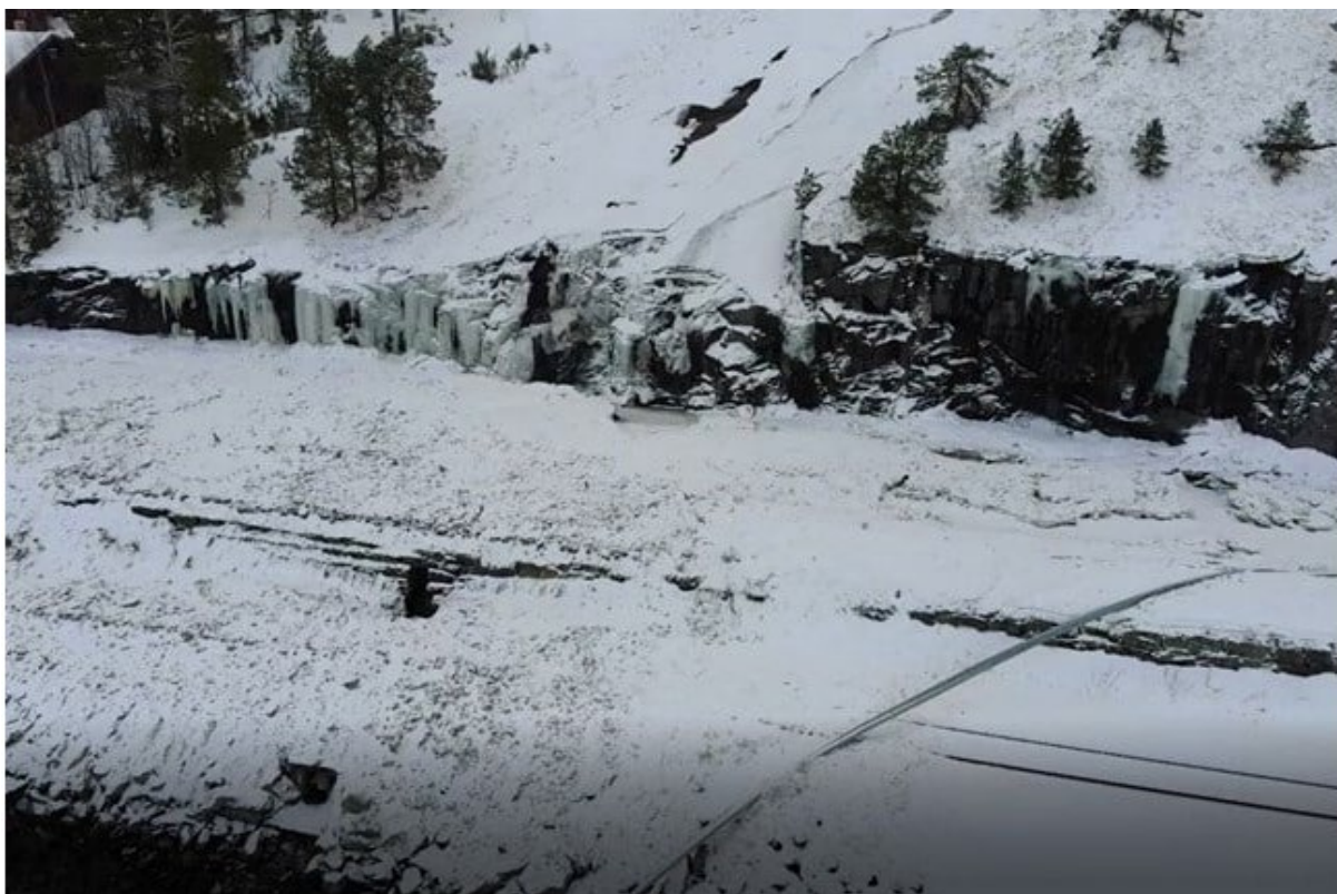
Figur 6-5 Sørpeskred ved Kistrand på Rv. 80. Bilde er tatt torsdags morgen 20. januar (Foto: Dag Theodor Andreassen, Statens vegvesen).
