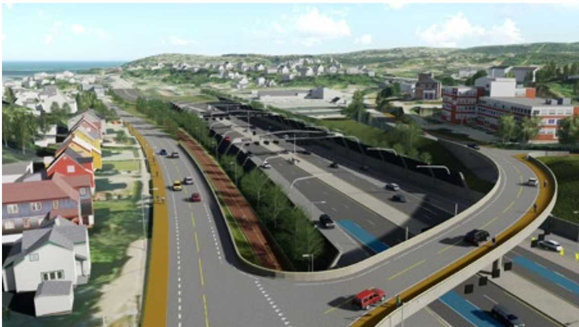
På E18 Ramstadsletta skal det bygges ny E18 i dagen som kobler seg på eksisterende E18 omtrent ved Solvikveien.
