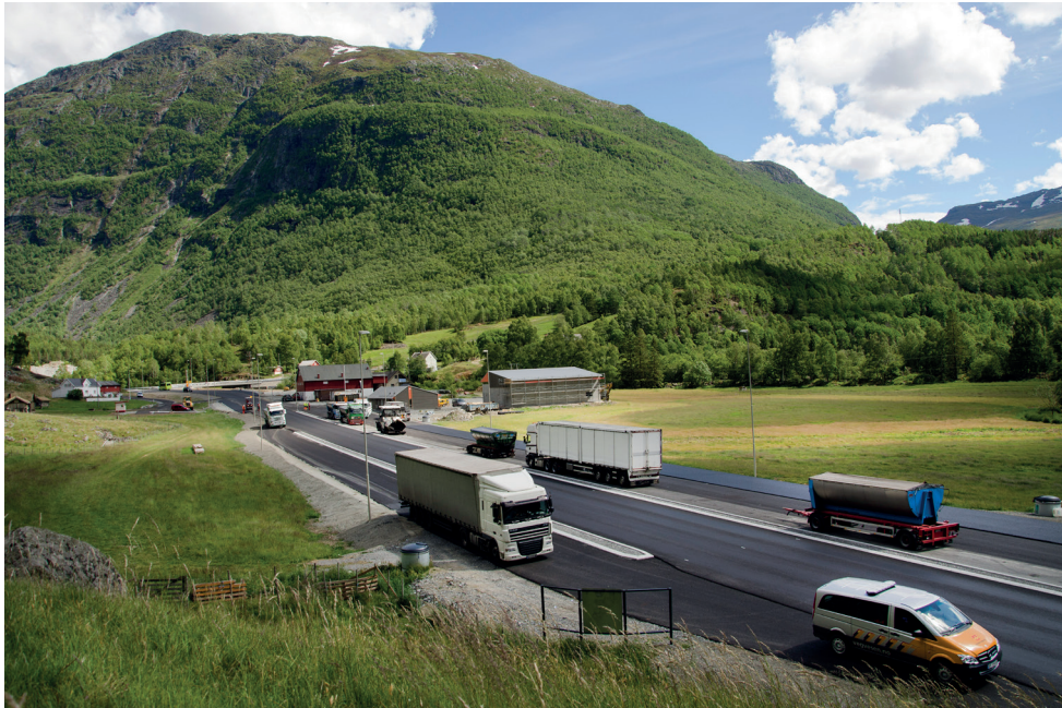
Ny kjettingplass og kolonnefelt i Borlaugskrysset.
