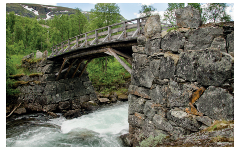
Gamle murar og nyrestaurert bru i Honingane.
