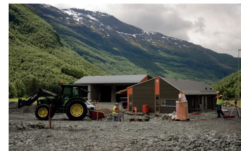
Det nye brøytestasjonen i Borlaugskrysset.
