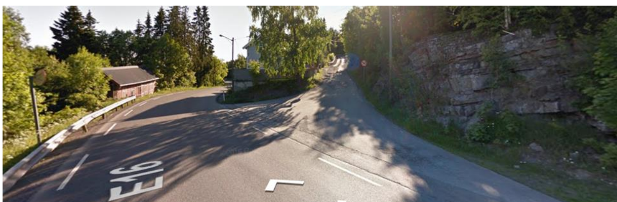
Foto 2: Kryss E16 x Fv. 2 Klinkenbergveien. Busser i retning Jevnaker stopper i krysset. Bolig midt i bildet og uthus til venstre i bildet er revet. (Google Street View)
