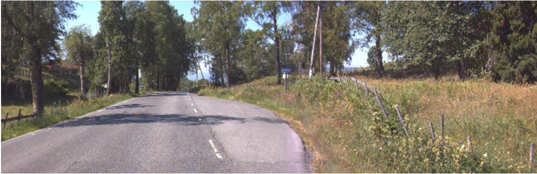
Foto 3: E16 sett mot vest ved Østre Olum. Planlagte tiltak vil gi inngrep i arealer bak buslomma til høyre i bildet, og langs vegen til venstre i bildet. (ViaPhoto 2018)
