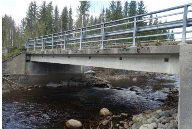
Figur 3-3: Betongbjelkebru, 05-1756 Synna. Hentet fra Brutus.
