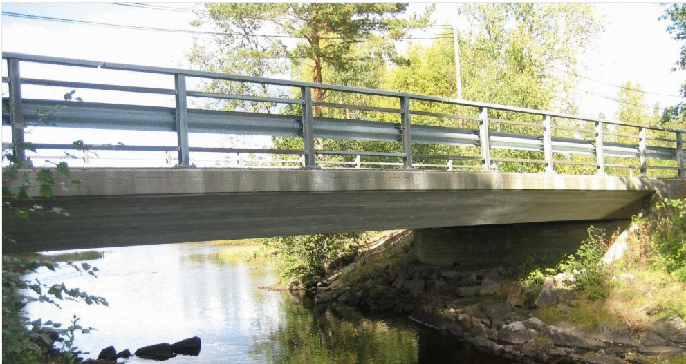
Figur 3-2: Betongplatebru, 04-1599 Digernes bru. Hentet fra Brutus.
