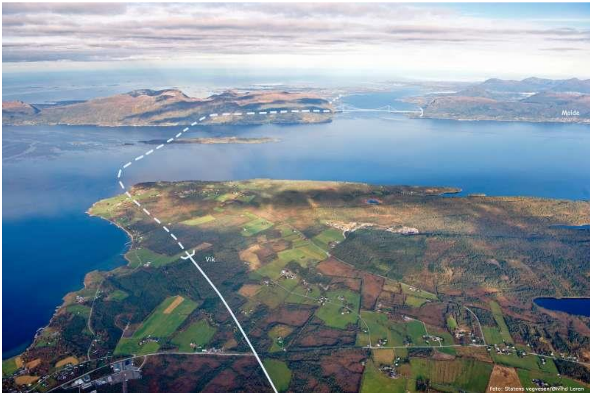
Figur 8 - Vedtatt løsning for kryssing av Romsdalsfjorden med tunnel Vik-Otrøya (stiplet linje) og hengebru Otrøya-Julbøen. Mulig tilknytning til Gossen (prikket linje).
