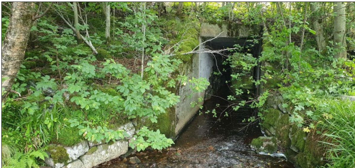
Figur 22 Viser Mordalselva med kantvegetasjon og eksisterende kulvert under fv. 662. Foto: Statens vegvesen/Arne Kavli
