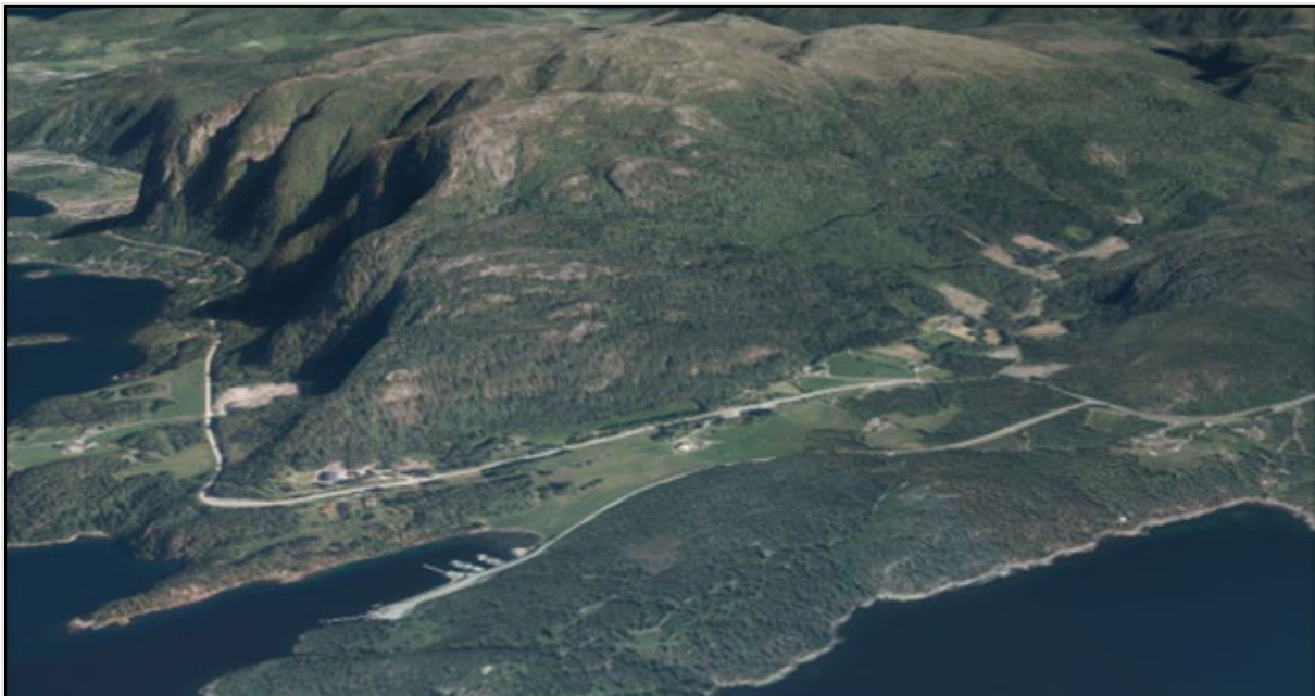
Figur 11 Eksisterende situasjon. Fv. 662 ligger i foten av Julaksla. Fv. 668 ses i framkant med ferjekai og småbåthavn. Kilde: 3D-bilde fra www.norgebilder.no
