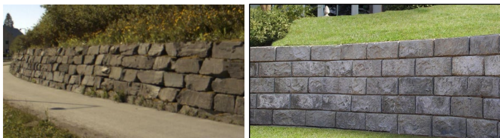
Figur 42 Eksempel på murtype som kan benyttes langs gang- og sykkelveg, til venstre natursteinmur, til høyre betongmur.
