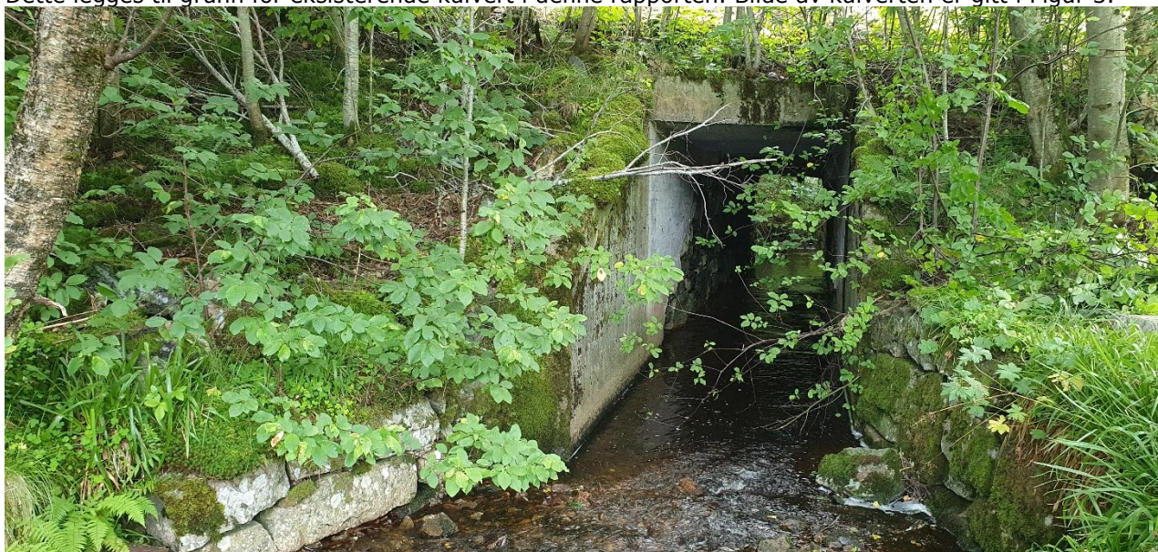
Figur 3 viser eksisterende kulvert under FV662. Bildet er tatt under befaring av SVV.
