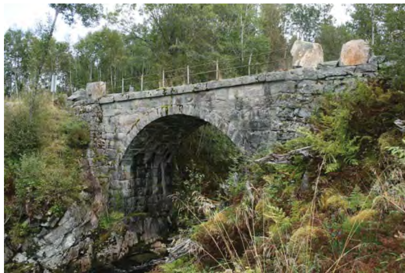
Fig.40: Steinkvelvsbrua over Klettaelva. Foto GMS.
