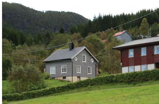
Fig.42: SEFRAK-registrert bustadhus frå slutten av 1800-talet må rivast. Foto: GMS
