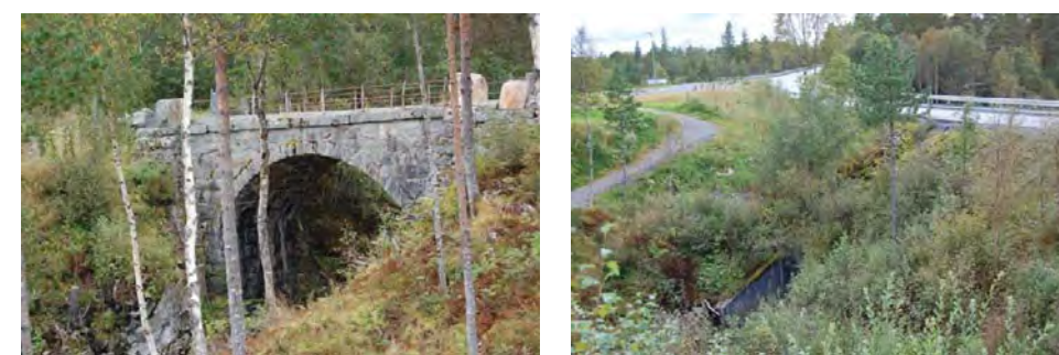
Fig. 53: Steinkvelvingsbru og kulvert for Klettaelva. (Foto: IV)
