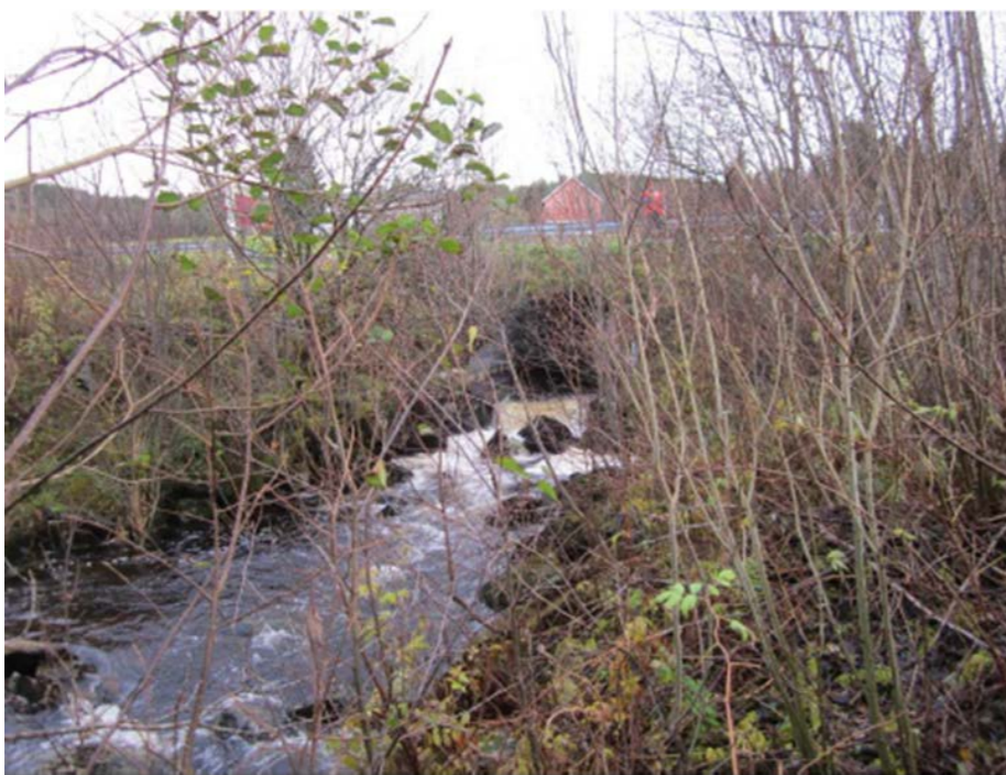
Figur 13 Bildet viser der eksisterende E39 krysser Stokkelva. (Foto: Torgeir Moen)
