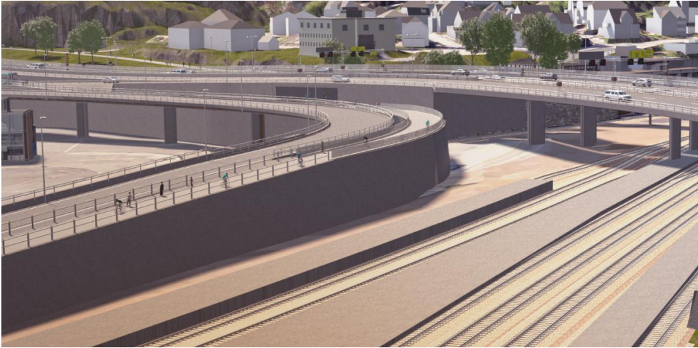
Figur 2.6.2 viser påløpsfylling for Havnegata bru og Havnegata G/S bru. Vestre landkar for bru over jernbanen vises også i bakgrunnen.
