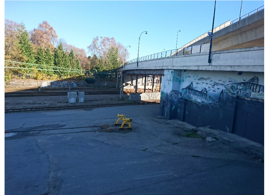
Lavbrua legger begrensninger på utvikling av jernbanen pga. høyde Vestervei brua fra 1938 (80år)
