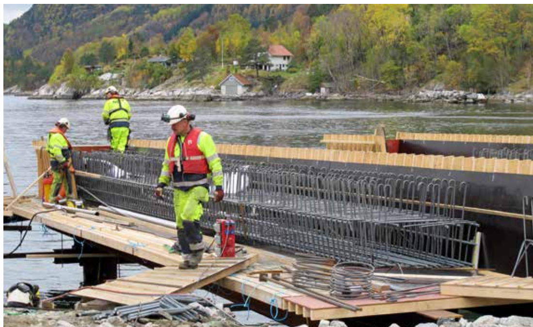
Arbeidet med å forskale og støype bjelkane som skal bære den nye ferjekaia er no i gang.
