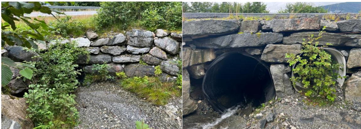
Figur 4.2. Bildet viser eksempler på sårbarhet for gjentetting av vegetasjon i kulverter ved analysefelt 3 – Skafjellgjølet (venstre bilde) og analysefelt 10 – Synnøvekleiva (høyre bilde).
