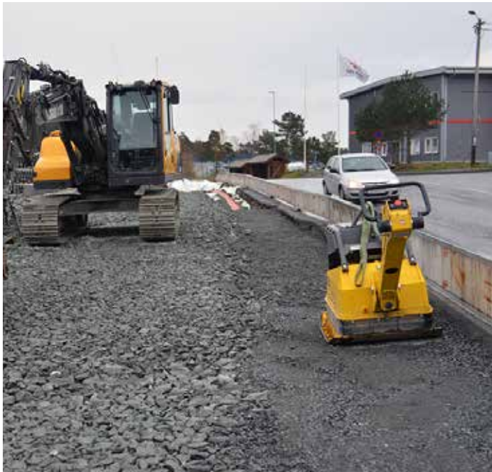
Bygging av ny busslomme i Kolskogheiane.
