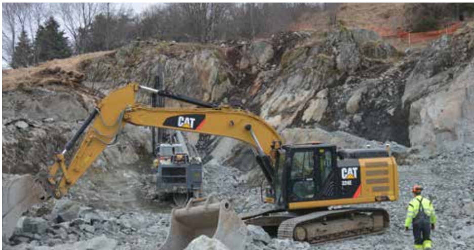
Maskiner som jobber ved det som blir påhogget til tunnelene.
