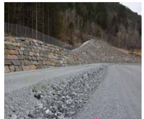
Langs Ulvenvegen er det bygt ein natursteinsmur på 1.700 kvadratmeter.
