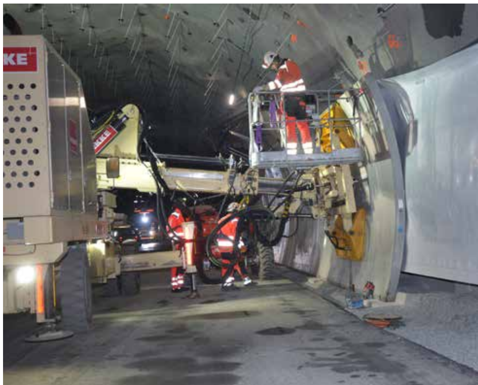
Montering av vegg-element i Skogafjellstunnelen.
