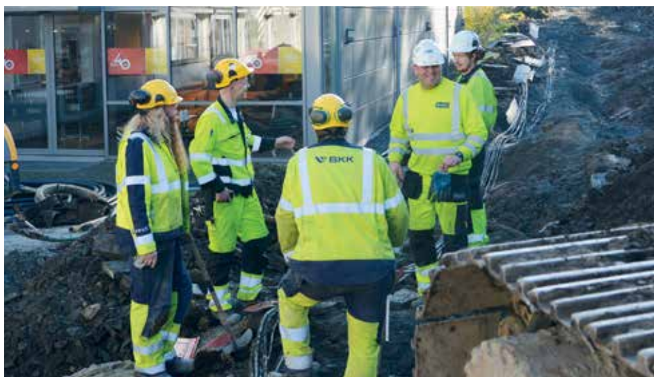
Entreprenør og energiselskap samarbeider om anleggsarbeidet tett inntil Bohus på Nordås.
