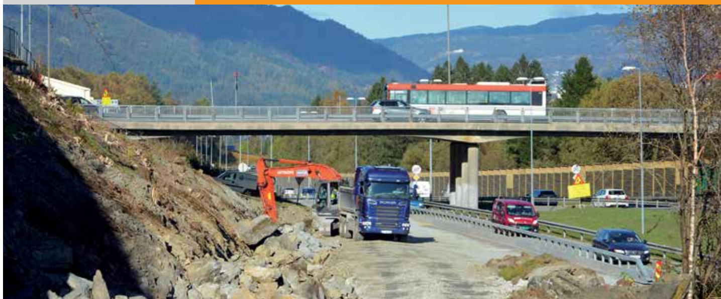
Søråsrampen under bygging.
