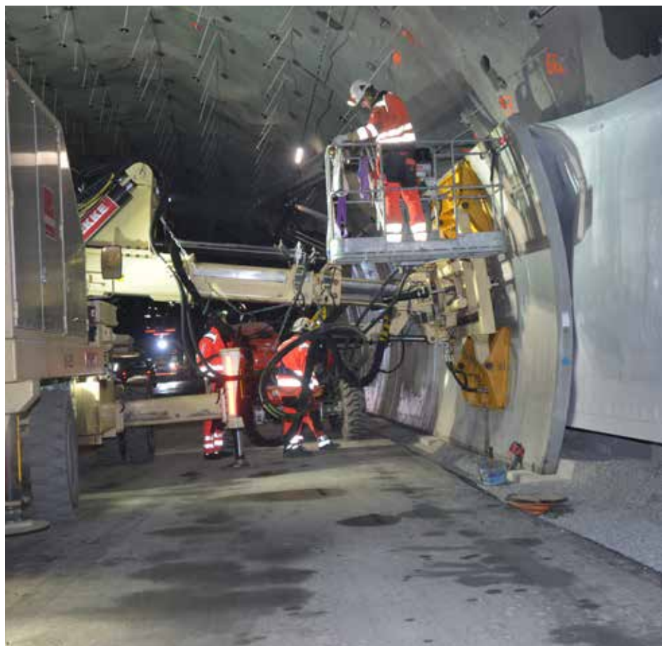
Det vil etter hvert komme i gang innredningsarbeid også i Rå- og Søråstunnelen. Montering av veggelementer er eksempel på dette. Bildet er fra slikt arbeid i den sørligste tunnelen i prosjektet, Skogafjells-tunnelen i Os.
