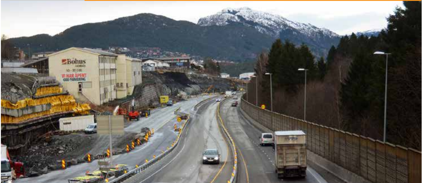
Rv. 580 Fritz C.Riebersveg mellom Sørås og Nordås vil bli innsnevret fra fire til to kjørefelt. I første omgang blir de to feltene liggende til venstre på bildet, inn mot møbelforretningen til Bohus. I en senere fase vil de to kjørefeltene bli flyttet ut til høyre, inn mot støyskjermen.
