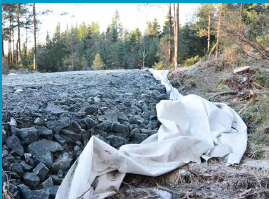
Kring 1.200 m anleggsveg er lagt på duk.
