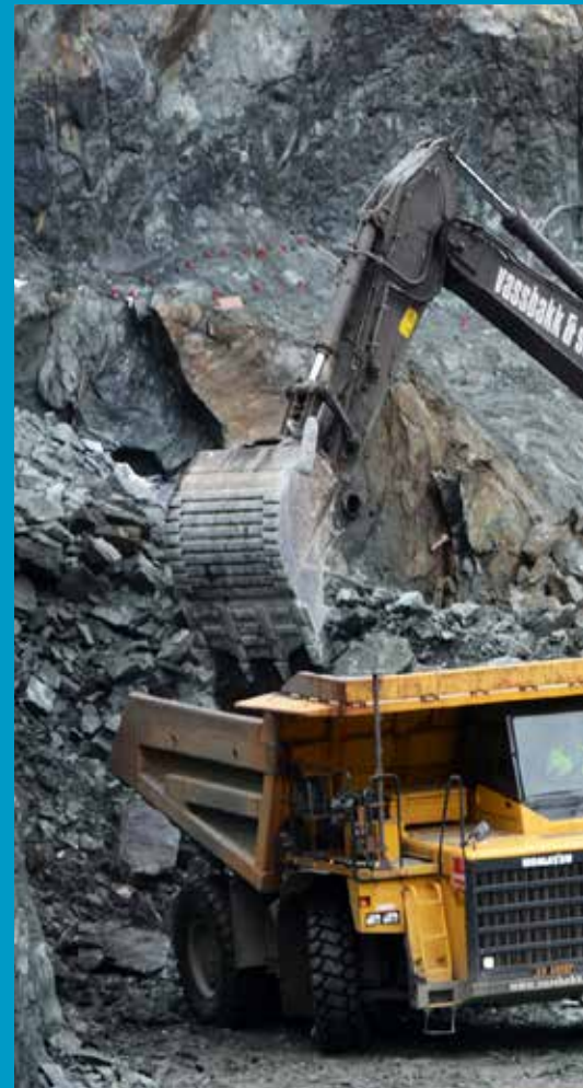
Bygging av E39 i Endalausdalen i april 2016. Innslaget til Ly
