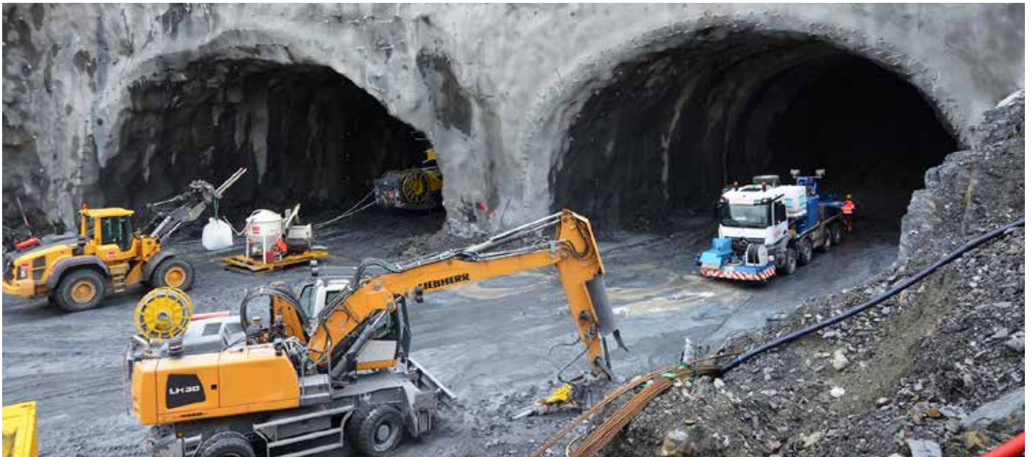
Skogafjellstunnelen ved Svegatjørn.
