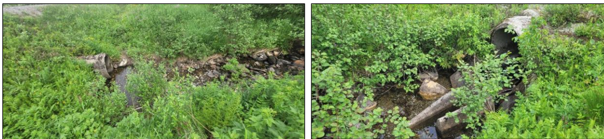
Figur 15 Bekk med fint bunnsstrat. Betongelement nedstrøms bør fjernes. Trolig fiskeførende dersom ikke for bratt mot Namsen. Bør undersøkes.
