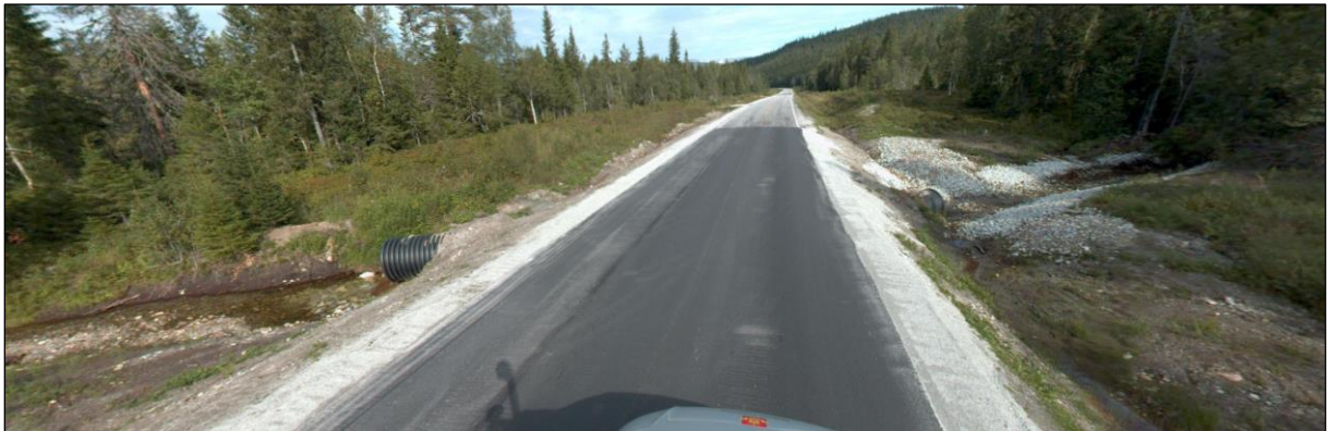
Figur 29 Bekken nord for Sagbekken. Ø1200 mm. sett mot nord.
