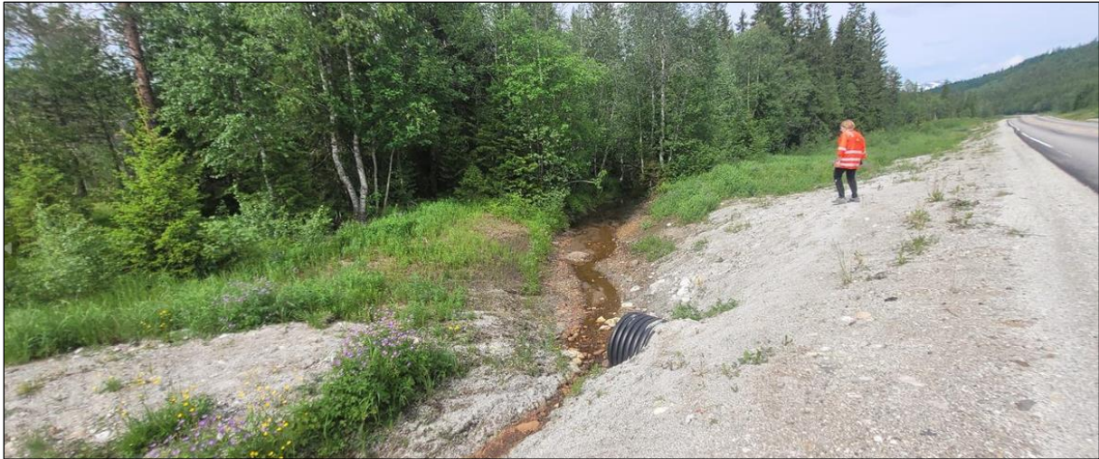
Figur 24 Bekk sør for avkjøring til Namstad steinbrudd. Ø800 mm (samme som bilde over). Fin bekk med bunnsstrat. Renner ut i Sagbekken vest for E6.
