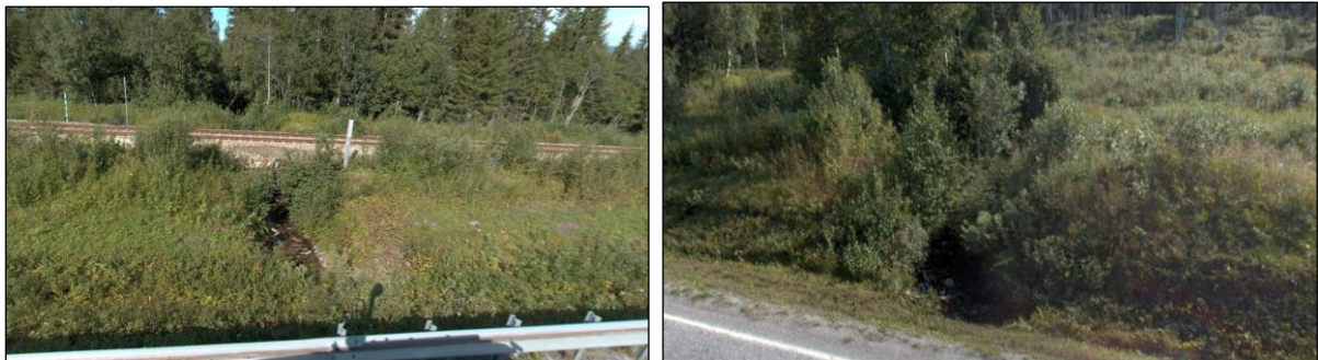
Figur 56 Bekk langs næringsarealet er mulig fiskeførende da den ligger åpen mellom jernbanen og næringsarealet. Ø800 mm på E6.
