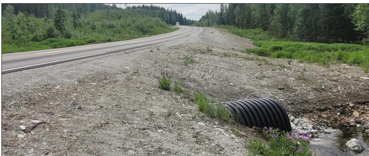
Figur 17 Nye stikkrenner og utslaking av sideterrenget til E6 på strekningen sør og nord for Russlerleiren. Utført 2020–2022.
