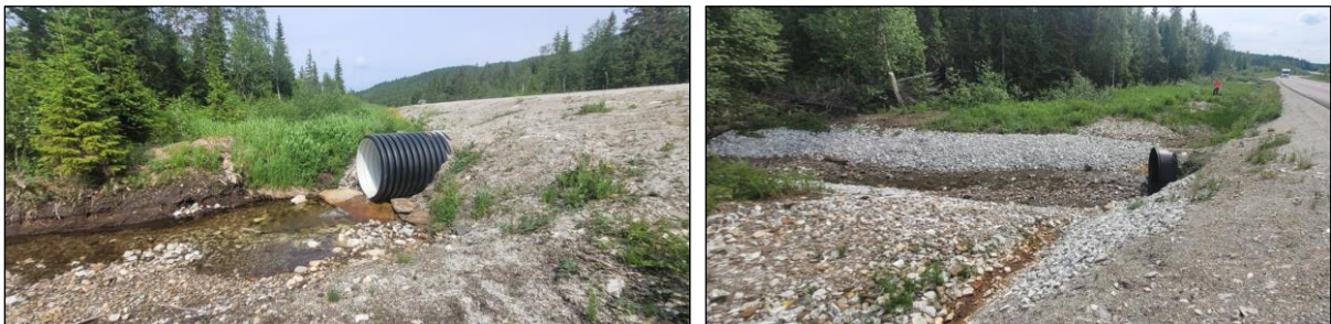
Figur 30 Bekken nord for Sagbekken, nedstrøms til venstre. Ø1200 mm.
