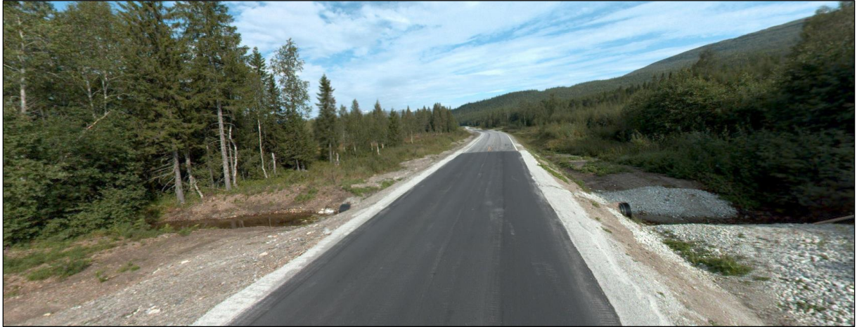
Figur 22 Bekk ved driftsavkjørsel/-lomme sør for avkjøring steinbrudd. Ø800 mm.
