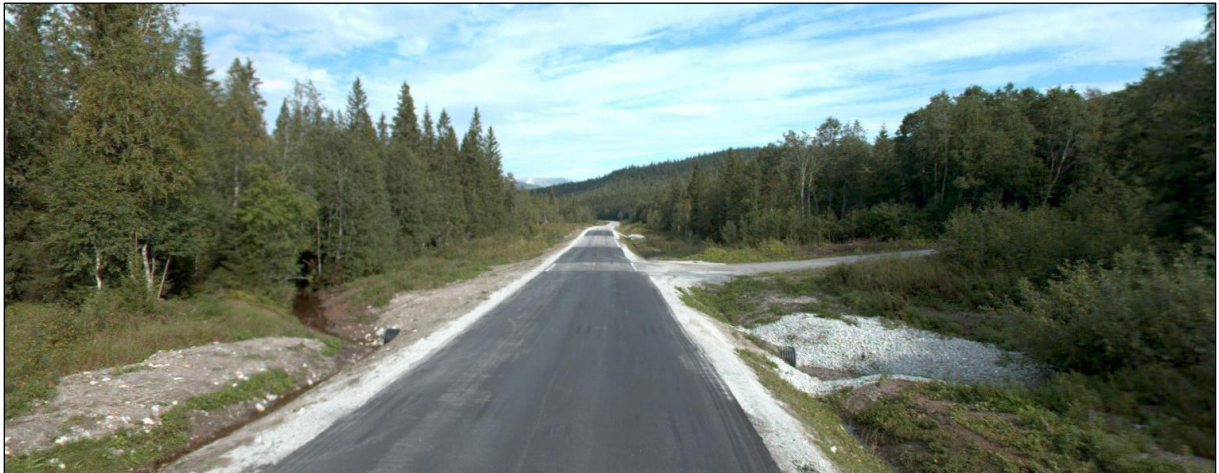
Figur 23 Avkjøring til Namstad steinbrudd, sett mot nord og Russerleiren. Ø800 mm. Fin bekk.
