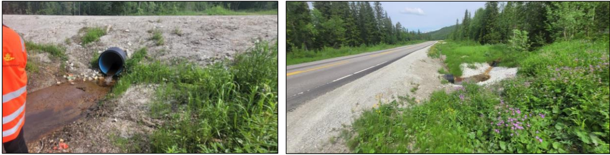
Figur 28 Sagbekken rett nord for avkjøring til Namstad steinbrudd, Ø 200 mm, skiftet 2020–22.
