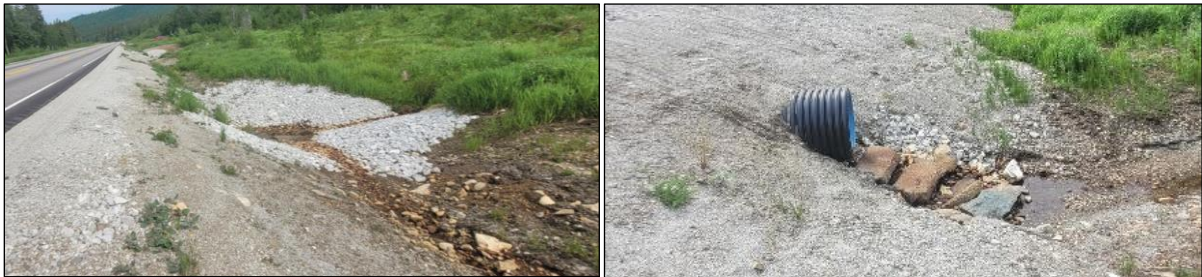
Figur 19 Sørligste bekk for steinbrudd. Trapping med betongelement nedstrøms, sør for Namstad steinbrudd. Terreng bør justeres og element fjernes. Utført 7. september 2023. Pukk bør dekket med jord og tilsåes svakt.
