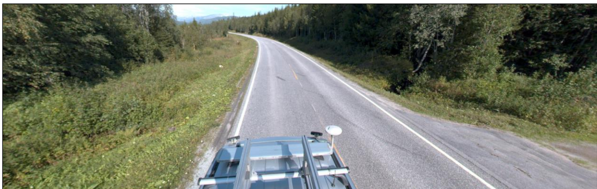
Figur 38 Bekk ved driftsavkjørsel nordligst ved Russerleiren. Betongrør Ø600 mm.
