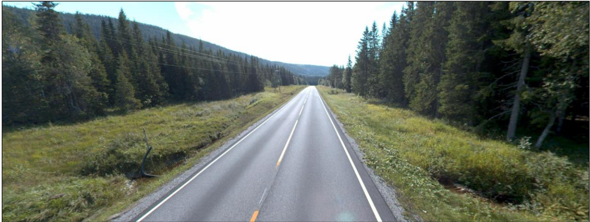
Figur 4 Bekk mellom Fosshheim og Fredvang. Liten bekk der det er åpent ved stikkrenne. Ø450 mm.
