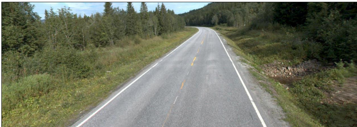
Figur 36 Stor bekk ved Russerleiren sør for driftsavkjørsel. Bekk er lite synlig fra E6. Betongrør Ø800.
