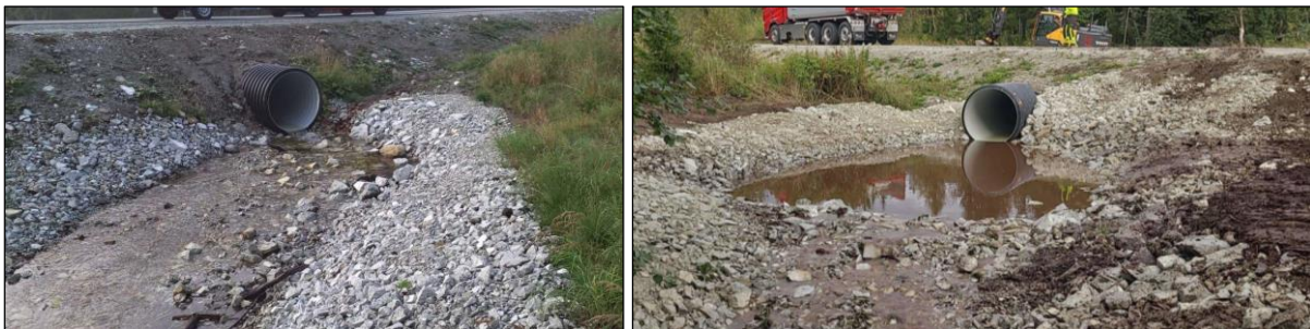
Figur 25 Stikkrenner ved Russerleiren som er utbedret i september 2023, 2 stk.
