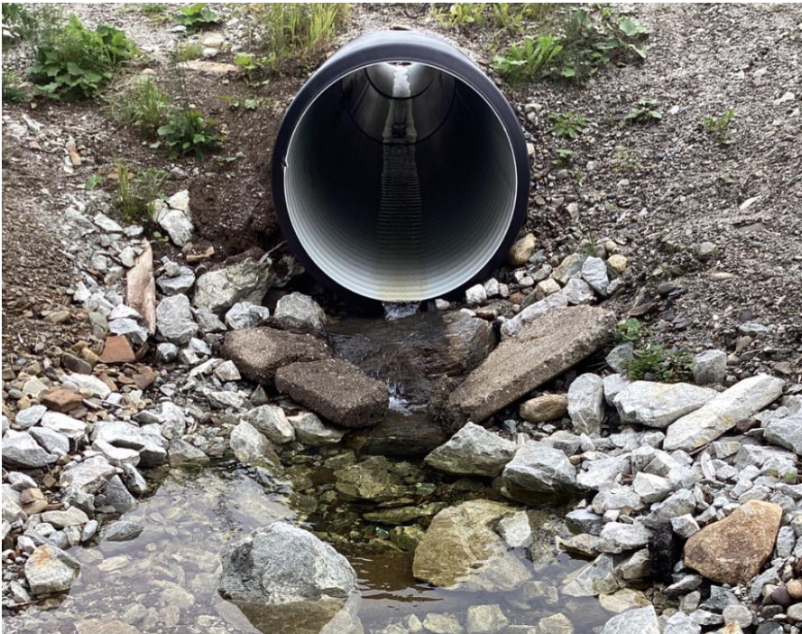
Figur 3 Eksempel på stikkrenne i navnløs bekk som ikke var egnet for fiskevandring
