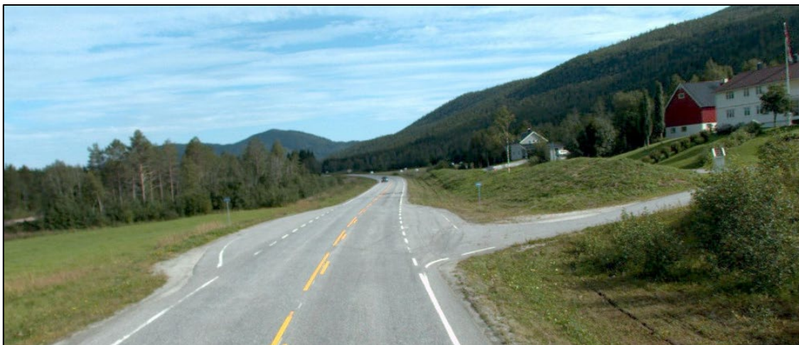
Figur 12 Bussholdeplass ved Syrstad, lommer på hver side av E6, sett fra sør. Kilde: SVV, vegbilder.no
