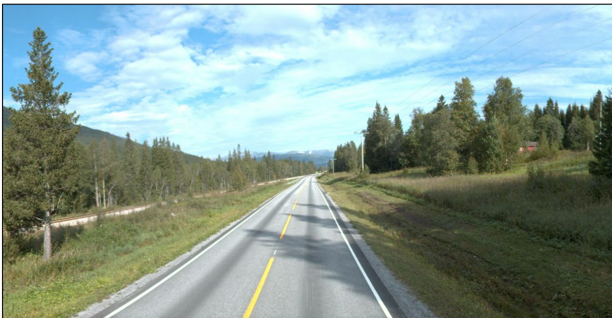
Figur 16 E6 og jernbanen ligger glir godt inn i terrenget i dag, men ligger i samme korridor over lengre strekninger. Namsen er lite synlig for trafikantene. Kilde: Vegbilder (vegvesen.no)
