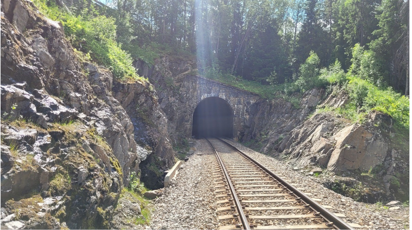
Foto 1: Påhugg nord Brekkvasselvtunnelen m 278 453
