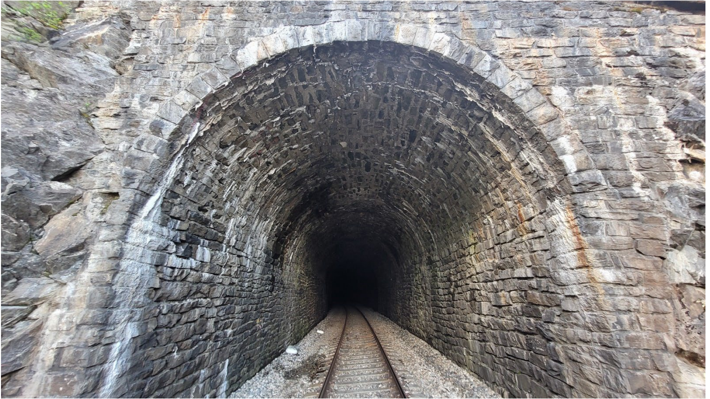
Foto 3: Tunnelinnslaget. Utstøpt i hele profilet fra ca. m 278 428 – 278 453 langs hele profilet og i venstre vegg (vestside) fra ca. m 278 415 – 278 428 i vegg.
