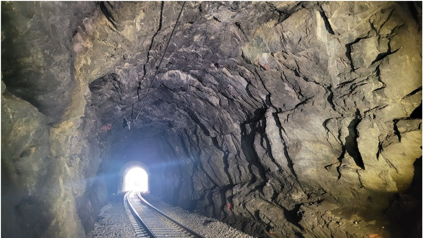
Foto 5: Foto tatt fra ca m 278 375 og mot nordre påhugg.
