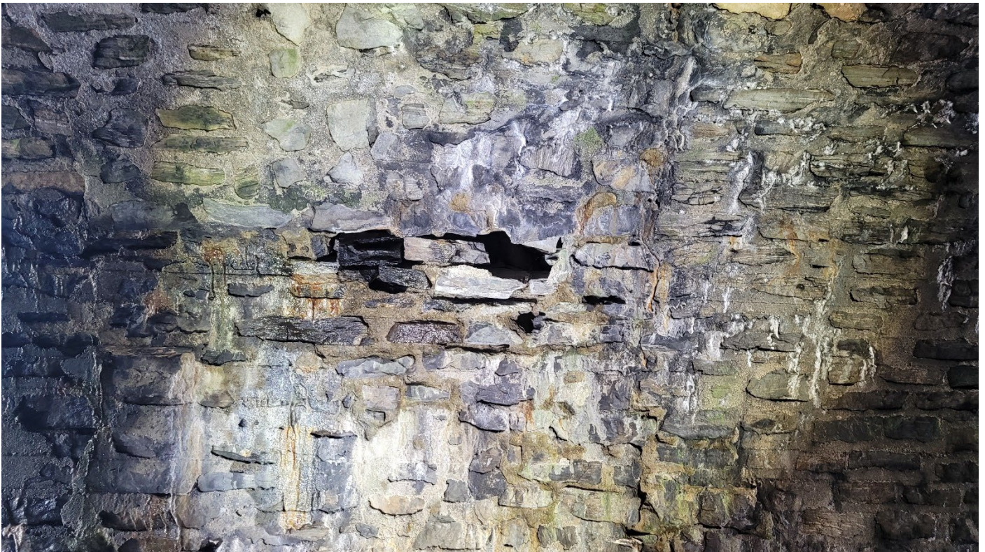
Foto 4: Ca. m 278 443 utfall i støp.
