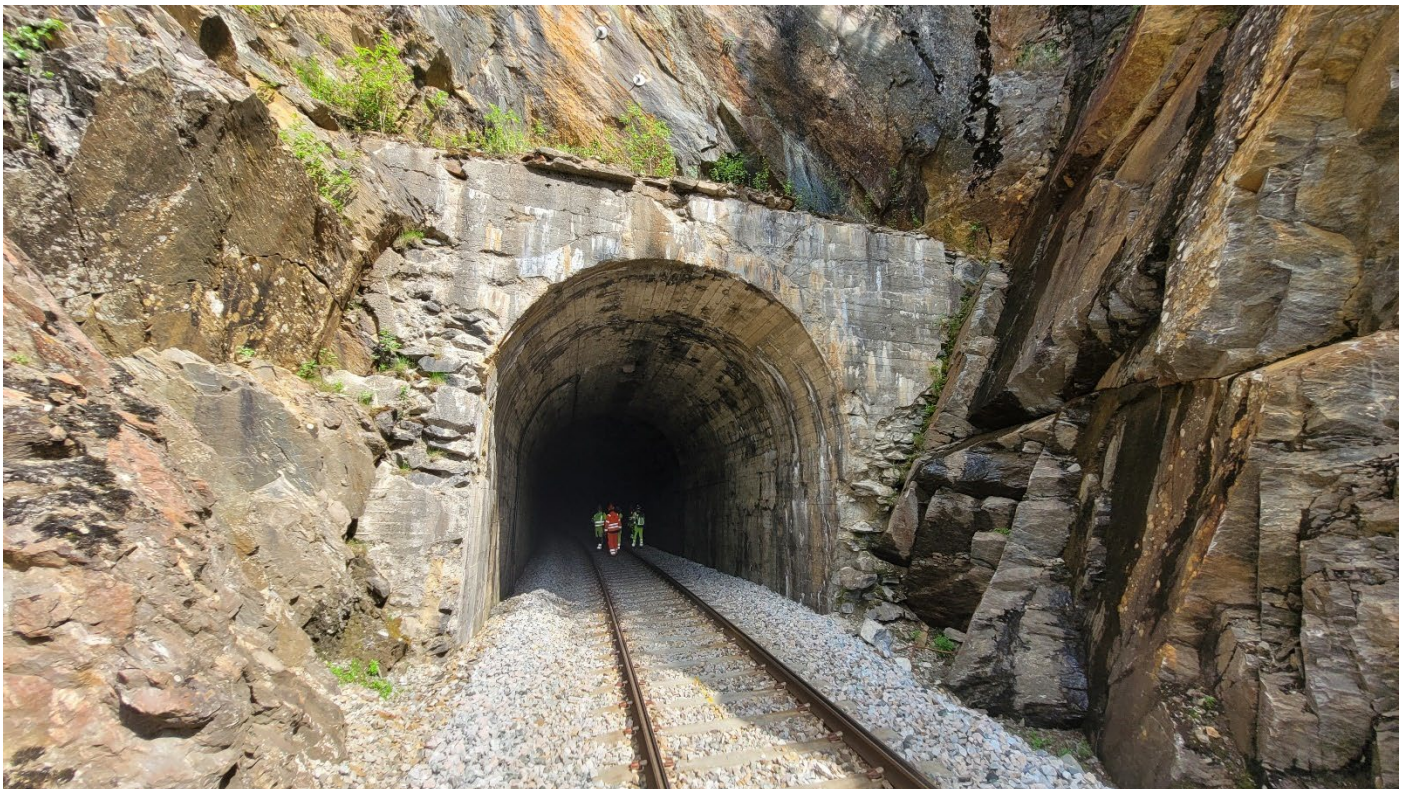
Foto 6: Sørlige tunnelinnslag m 279 383.
