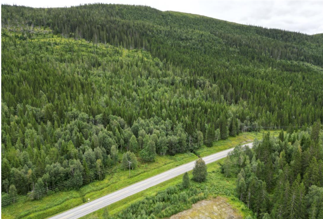
Figur 1: Oversiktsbilde veg og sideterreng ved pr. 3750. Bekkekrussinger ved pr. 3670 og 3740 er vist på bildet.
