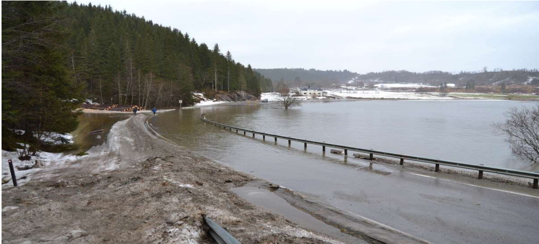
Figur 3 Bildet viser Fossland ved flommen 2 oktober 2015. Det gikk da ca. 2000 m 3 /s ved Fiskumfoss. Foto: SVV.
