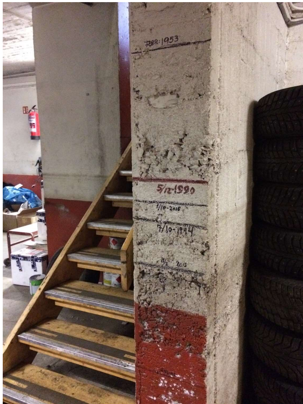
VEDLEGG 3. Høyde av flom ved Grong bilsenter. Foto: NVE
