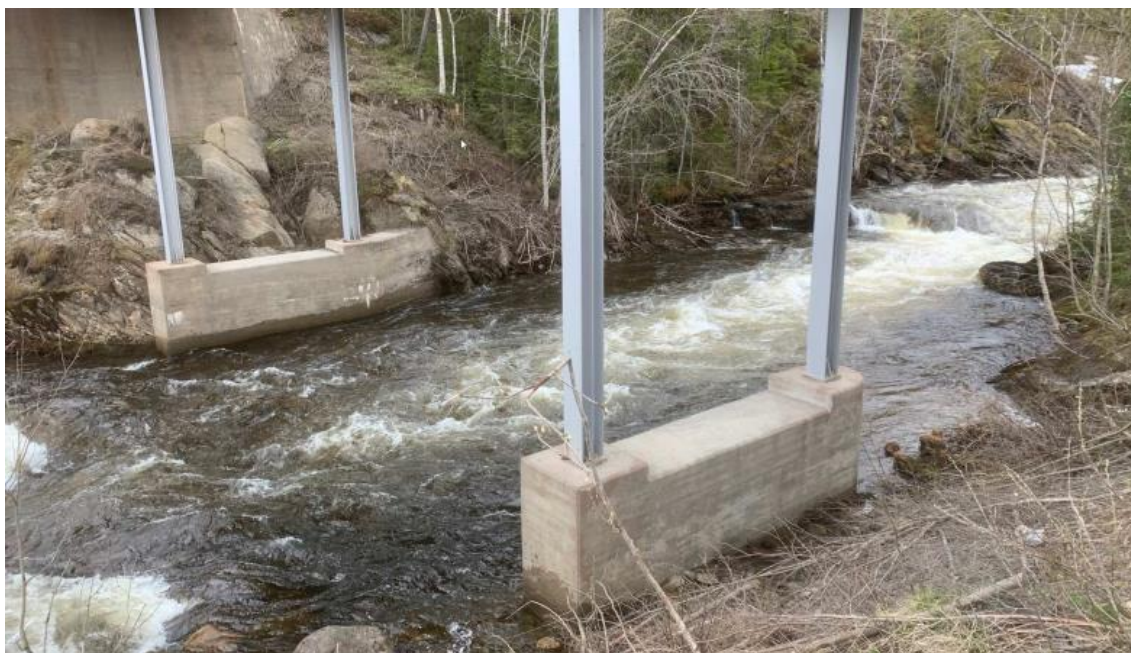
Figur 7: Støtteelementer for dagens bru i Brekkvasselva.
