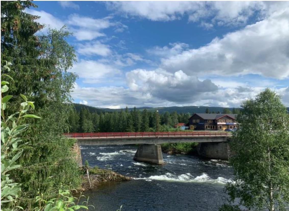
Figur 3: Håpnesbrua med et støtteelement i elva. Foto: Aas-Jakobsen.
