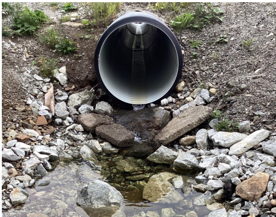
Figur 5 Eksempel på stikkrenne i Navnløs bekk midt som ikke var egnet for fiskevandring.
