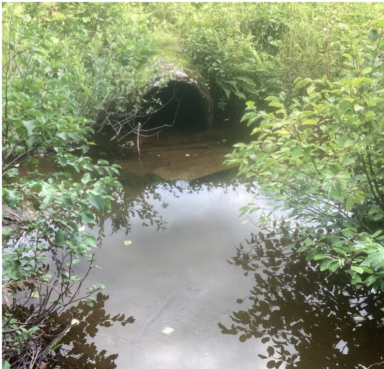
Figur 10 Stikkrenne under E6 godt utformet for fiskevandring.
